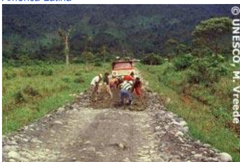
Construcción de una carretera que facilitará el acceso al Amazonas.
