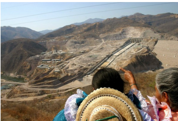
Presa el Cajón, Nayarit
