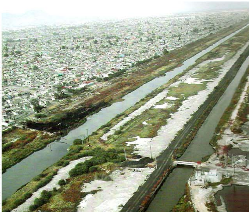
Canal abierto de aguas residuales, Fuente: Mostra di Architettura 2006, Venecia
