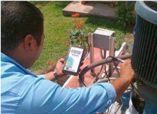
Figura 4.18 Medición en campo de nivel de vibraciones en un sistema de bombeo
