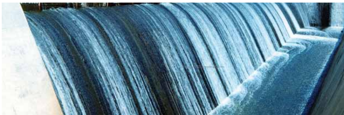
Fotografía de barrera mostrando vertedor de demasias de la presa en funcionamiento. Ixtlahuaca y Almoloya de Juárez, México, presa José Antonio Alzate, 1970
