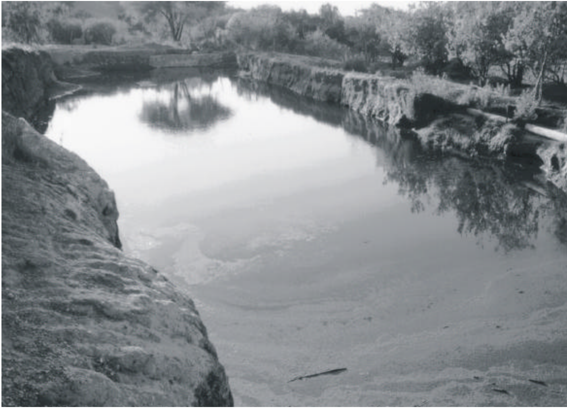
(100) Tanque regulador, San José Trujapan.
