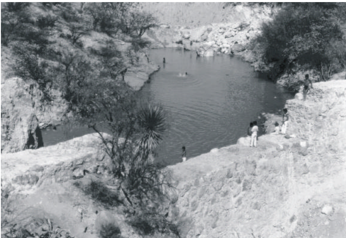
(90) Presa "Agua el Moral", Santa Ana Telóxtoc.
