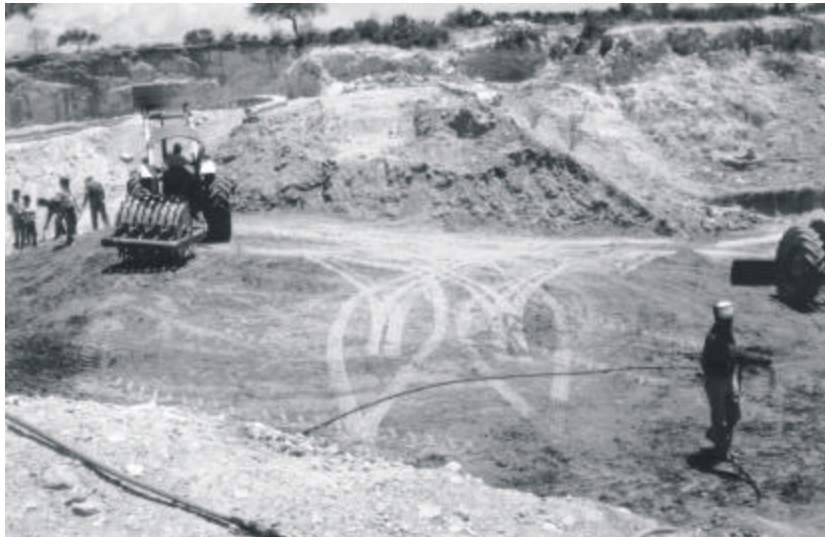
(88) Compactación de la presa de Santa María La Alta.
