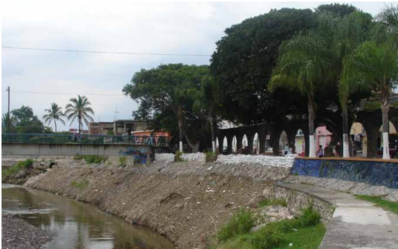
▲ Costalera de protección para río Yautepec, Municipio de Yautepec, agosto 2008
