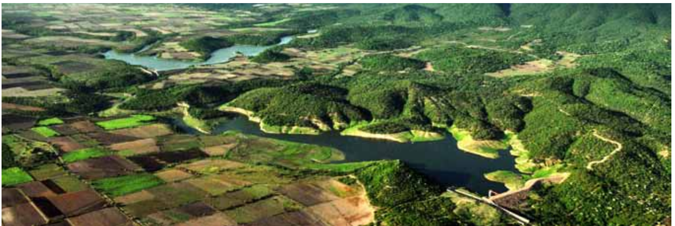
▲ Vista aérea sistema de presas Los Carros - Cayehuacan, Municipio de Axochiapan, julio 2010
