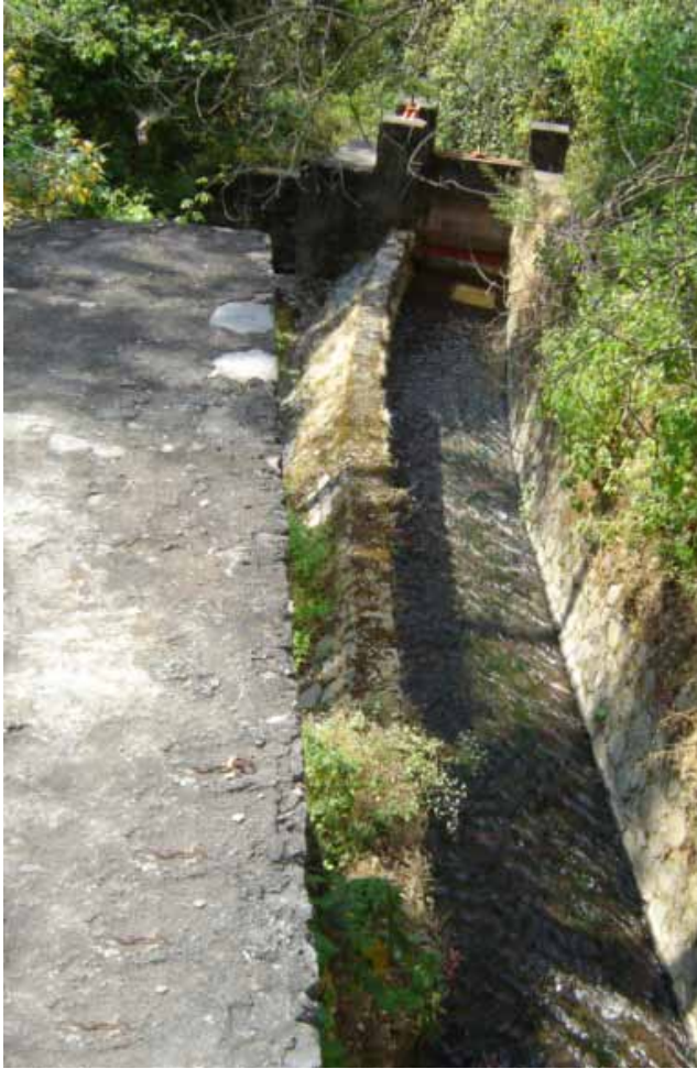
▲ Ferrería, primera derivadora de la cuenca baja de la barranca Amatzinac, Municipio de Tlacotepec, noviembre 2008
