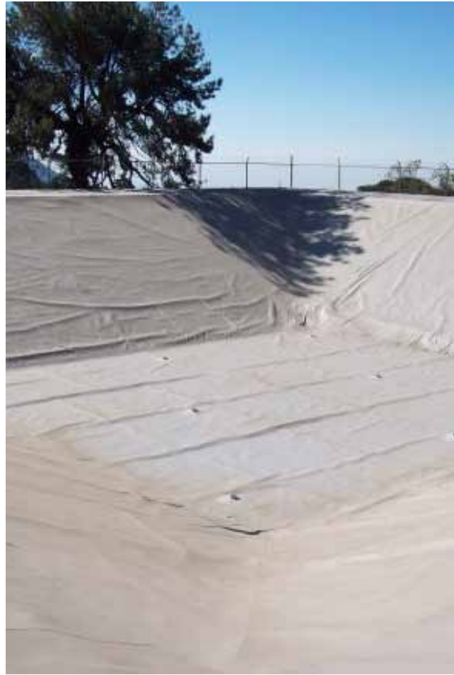
▲ Aplicación de membrana para olla de captación de aguas pluviales para abastecimiento comunitario, Altos de Morelos, Municipio de Huitzilac, marzo 2010
