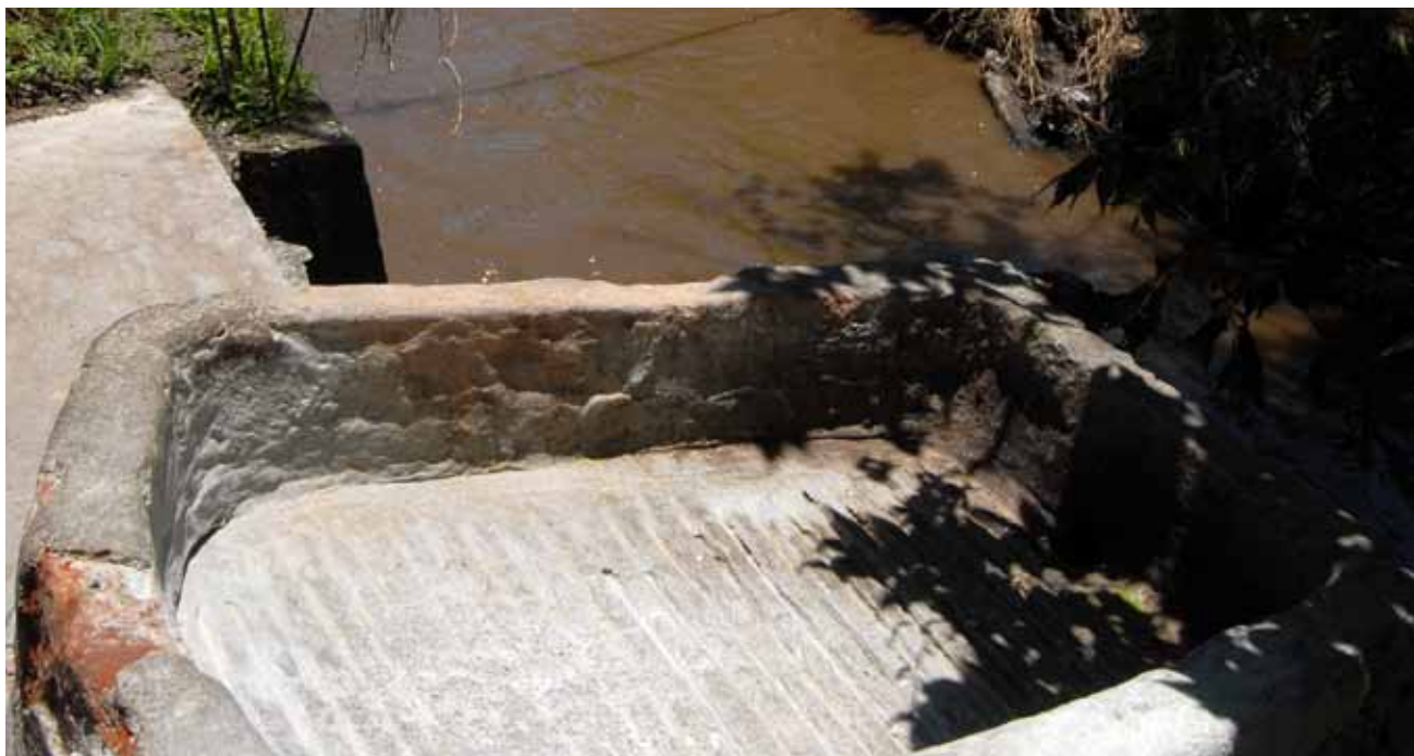
▲ Lavadero público, río Apatlaco, Municipio de Jojutla, julio 2010
