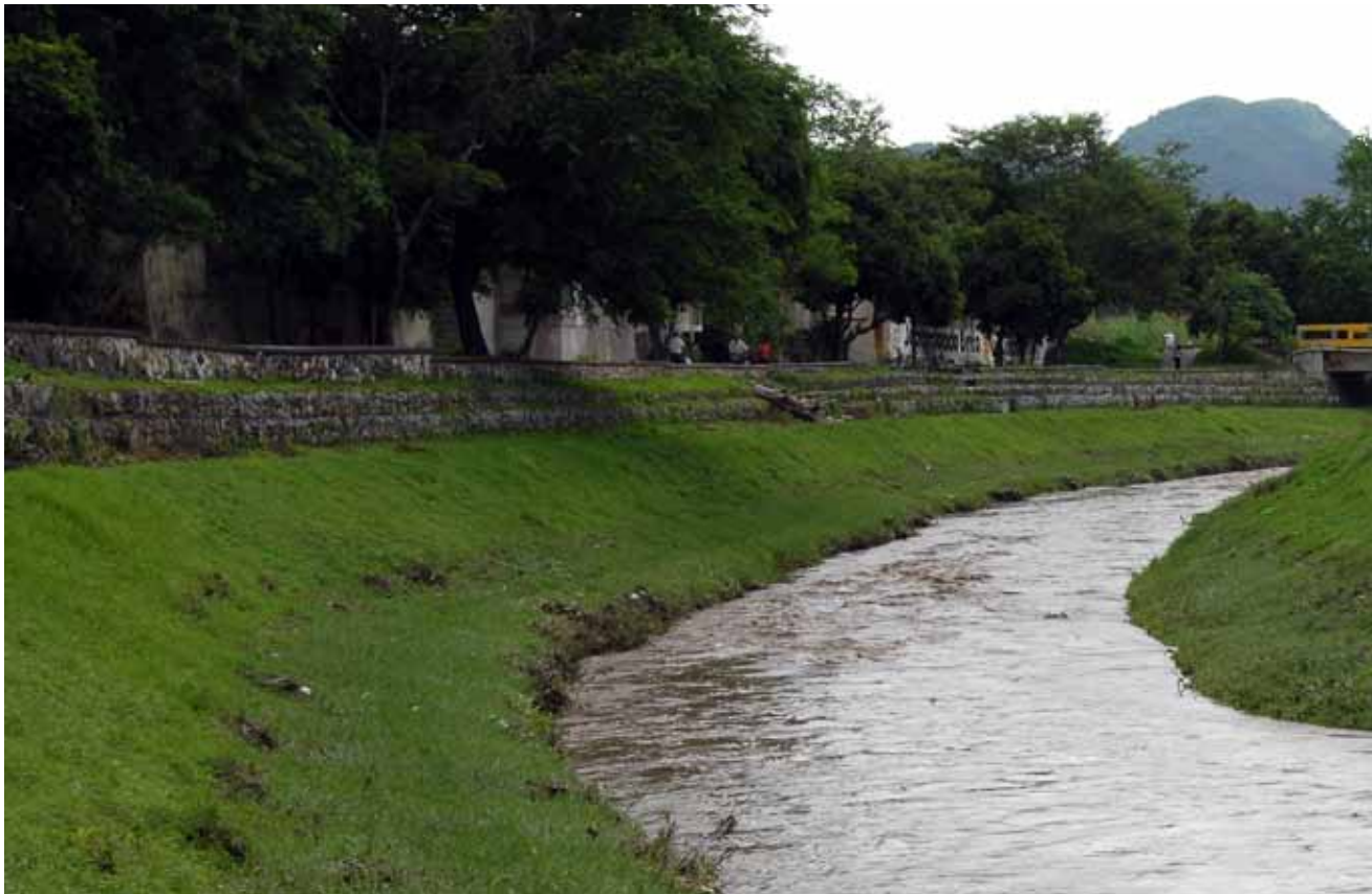
▲ Cauce río Cuautla, Col. San Felipe, Municipio de Cuautla, agosto 2010
