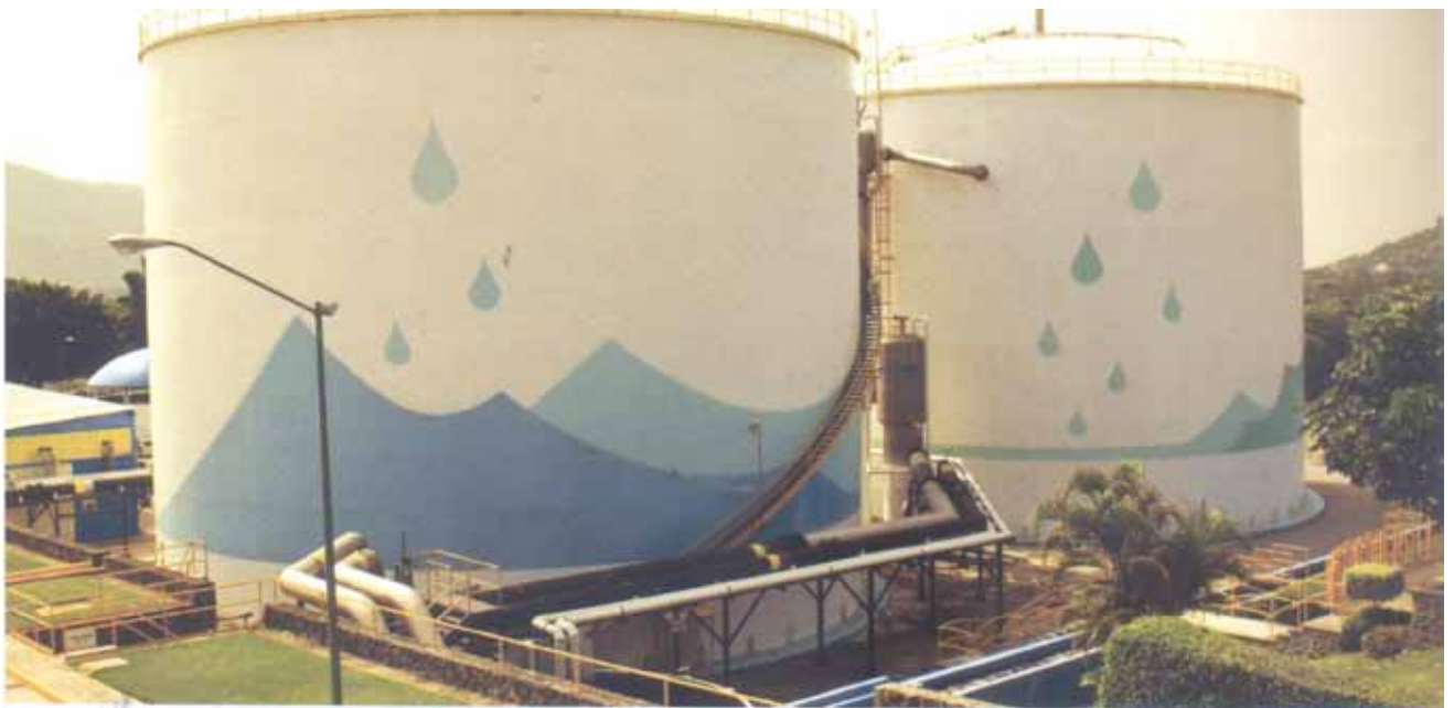
▲ Planta de tratamiento de aguas residuales de ECCACIV, Municipio Jiutepec, agosto 2008
