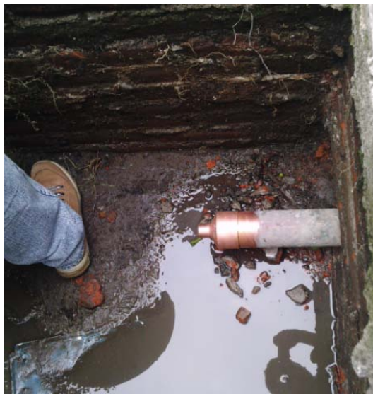
Figura 22. Reducción tipo Bushing para tuberías de cobre.
