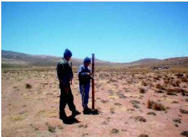
Construcción de cerco de alambre.
