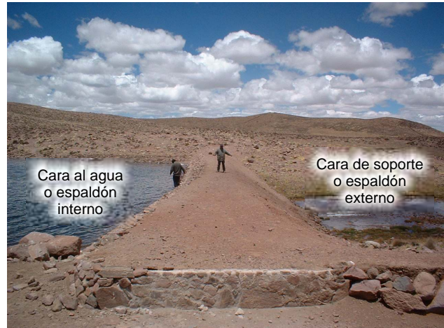
Estructura del dique microrrepresa Condorquiña, Chalhuanca, Caylloma.
