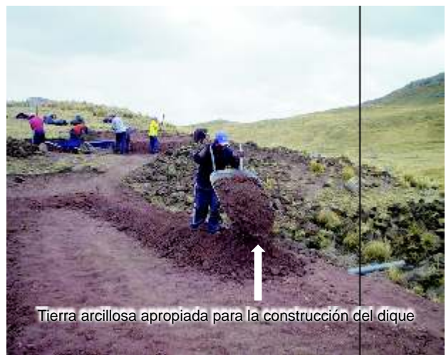
Colocación de tierra por capas.
