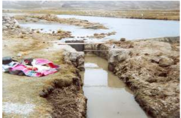
Bocatoma Casablanca, Chalhuanca, Caylloma.
