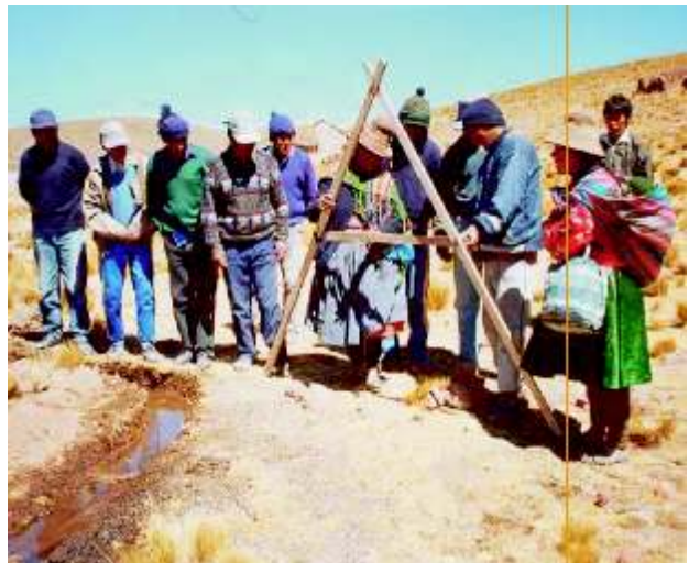
Realizando la nivelación y trazo.
