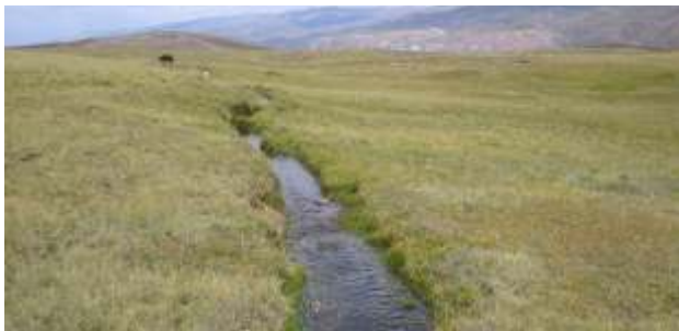
Canal protegido con gramíneas.
