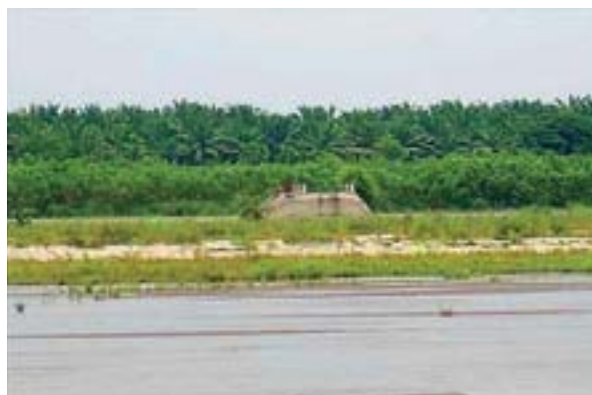
Obra de toma del distrito de riego mexicano en Guatemala.
