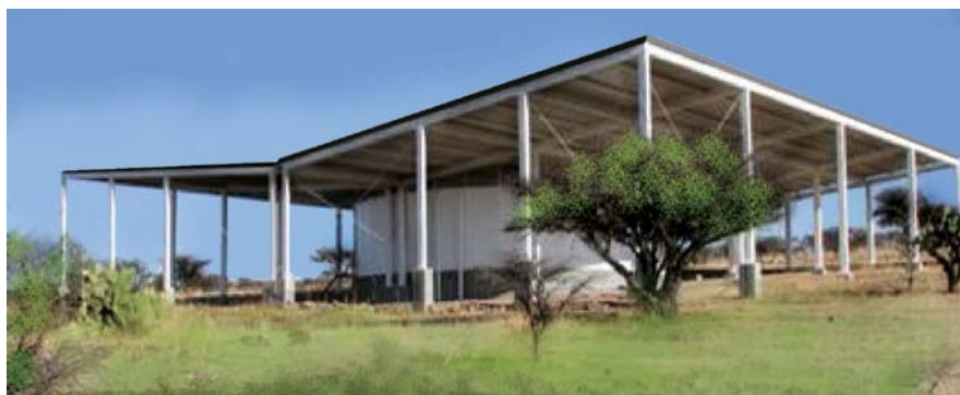
Figura 2.4. Techo de cuenca en la comunidad del Tecongo, Aguascalientes
