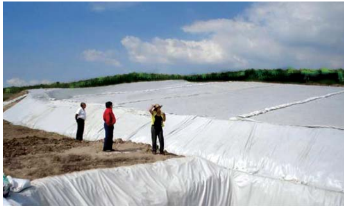
Figura 2.5. Ladera recubierta con geomembrana de PVC acondicionada como área para captación de agua de lluvia.
