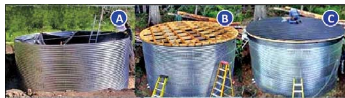
Figura 2.16 (a) Lámina galvanizada con tornillos, (b) Estructura del techo (c) material impermeable para evitar las pérdidas del agua por evaporación.
