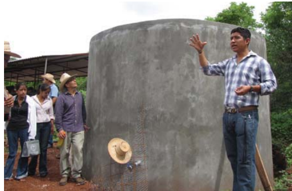
Figura 2.14. Cisterna de cemento tabique
