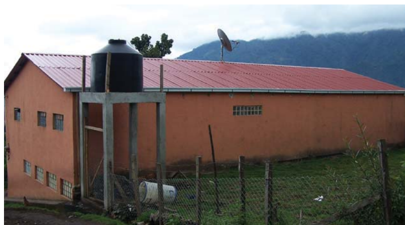
Figura 2.3. Techos de escuelas utilizados como áreas de captación del agua de lluvia.
