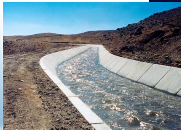
Canal colector Ingahuasi Huancavelica, Perú
