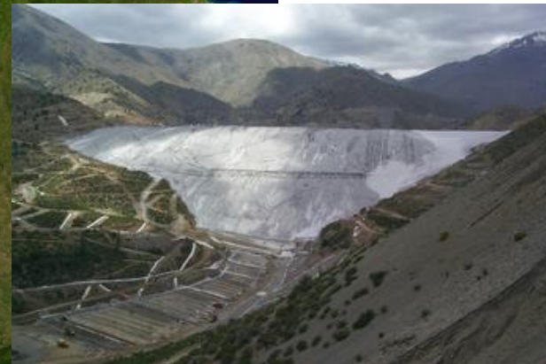
Tranque de relaves "Los Pelambres" Coquimbo, Chile
