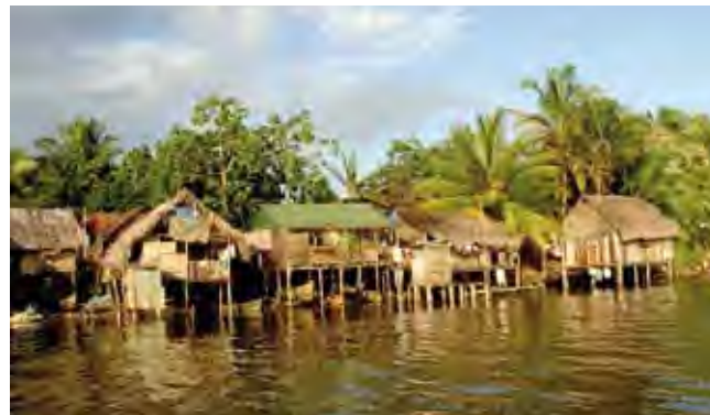
Foto 9. Algunos ejemplos de cómo deberían de construirse las viviendas en las llanuras de inundación, en las zonas medias.
