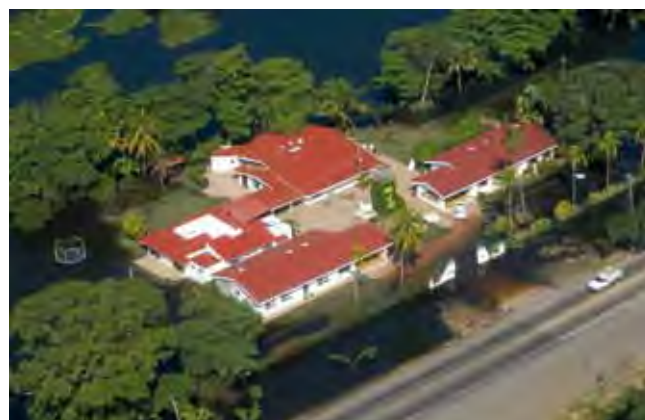
Fraccionamiento desarrollado en zona inundable.
