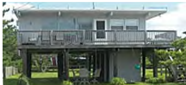
Foto 10. Otro ejemplo de cómo deberían de construirse las viviendas en las llanuras de inundación, en las zonas medias.
