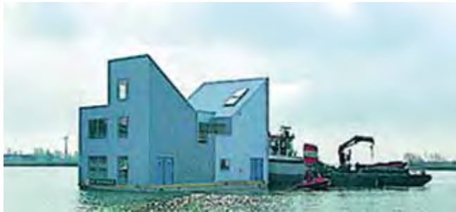
Foto 14. Una casa anfibia, remolcada a IJburg.
