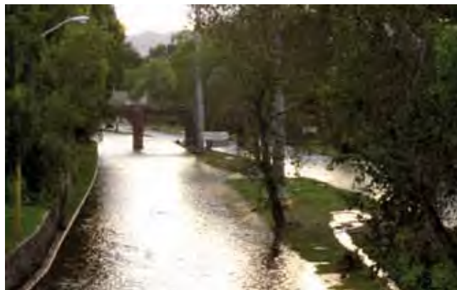
Foto 15. Boulevard sobre el cauce del río Santiago. Nótese que se ha respetado al máximo el área hidráulica. En esta vista la vialidad se encontraba cerrada por el inicio de una avenida.
