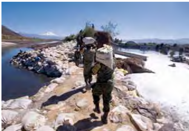
Foto 4. Construcción de bordos.
