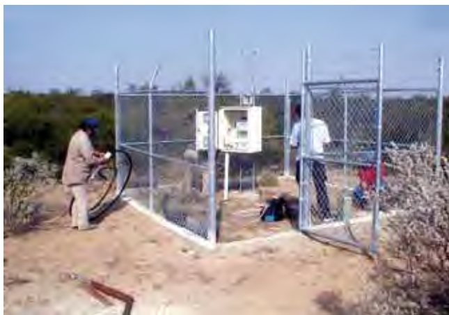
Foto 3. Instalación de la caseta de protección y caja NEMA de una PCD.
