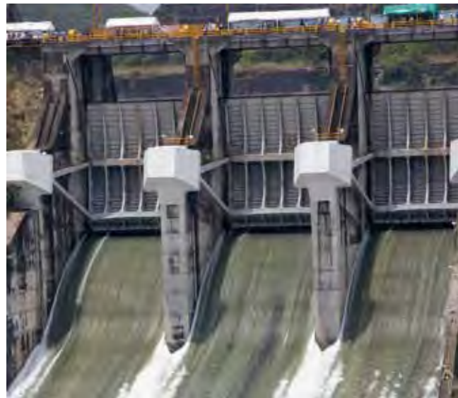
Foto 4. Características de la infraestructura de control a cargo de la CONAGUA.
