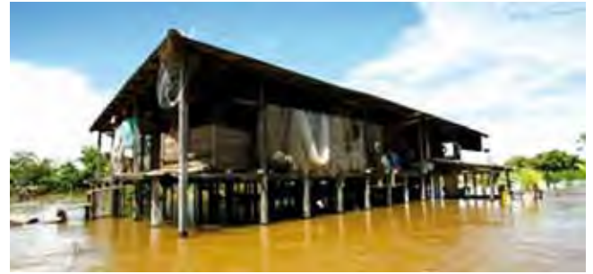
Foto 11. Otro ejemplo de cómo deberían de construirse las viviendas en las llanuras de inundación, en las zonas bajas.
