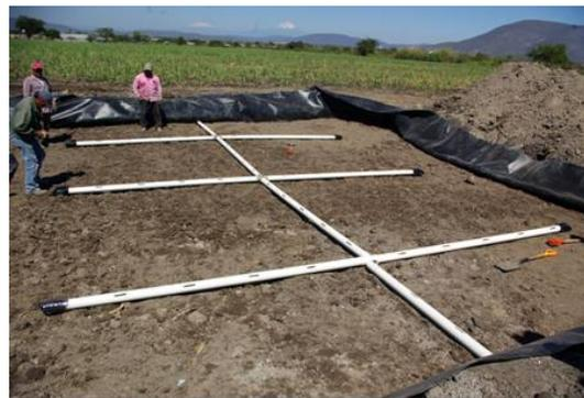
Foto 2. Construcción del prototipo de Humedal
