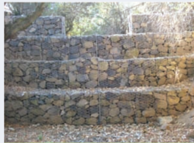
Muro de Contención
