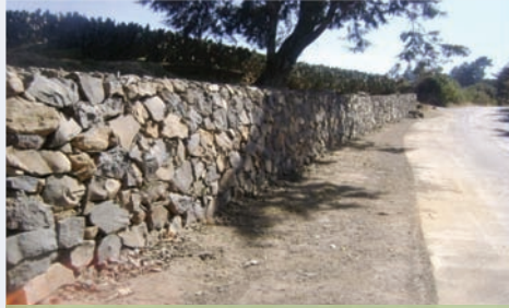
Muro de Piedra Acomodada
