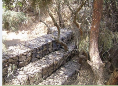
Represa de Gavión
