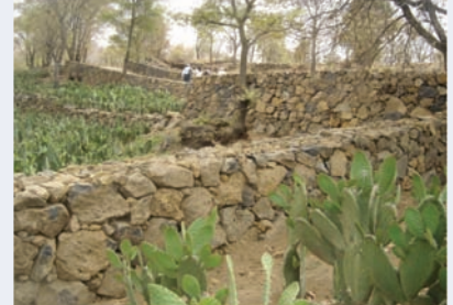
Muro de Piedra Acomodada
