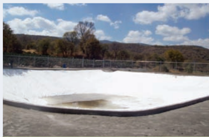
Hoya de captación
