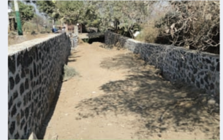
Muro de Contención
