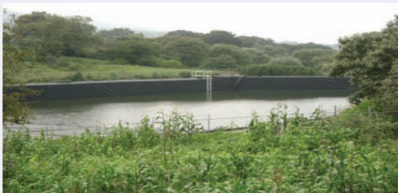
Hoya de captación
