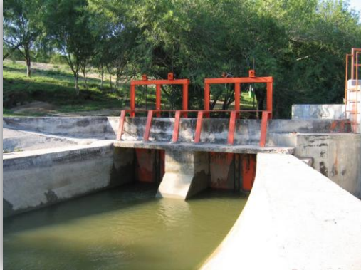
a) Obra de toma
