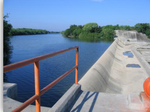
b) Obra de excedencias
