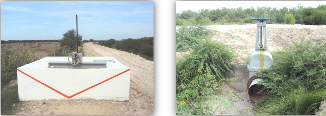
Figura 4.20. Obras de modernización (entubamiento de regaderas) en el módulo 4 del DR 004 Don Martín.
