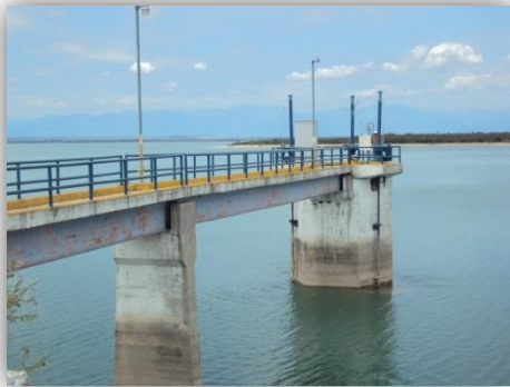
c) Obra de toma
