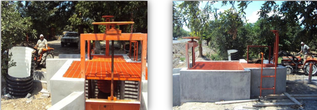
Figura 6.15. Obras de entubamiento de regaderas en la región citrícola.
