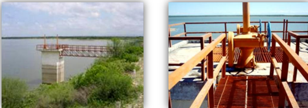
Figura 5.9. Obra de toma y mecanismos de la obra de toma de la presa José S. Noriega.
