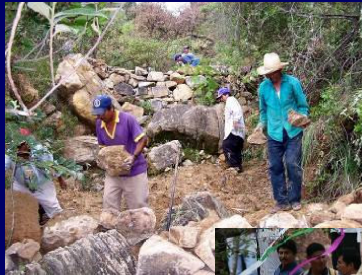
Construcción de obra(s)
