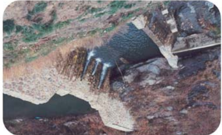
Dique en un torrente de Sierra Nevada (Granada). Lamina el caudal punta y aumenta la infiltración (Foto TRAGSATEC).
