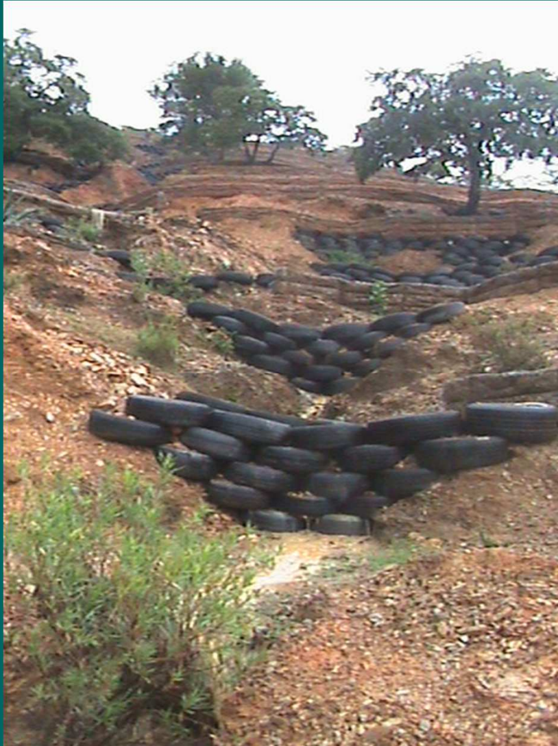
Trabajos de microgaviones y llantas en los arroyos
