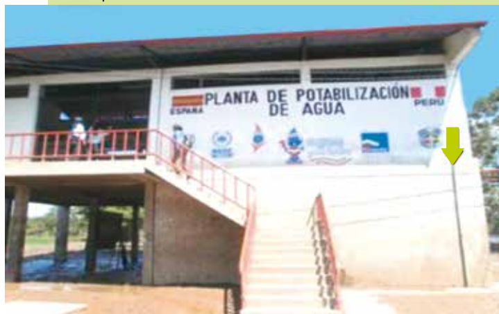
Foto 3. Planta potabilizadora de la comunidad de San Andrés afectada por la inundación. Belén 2012.
