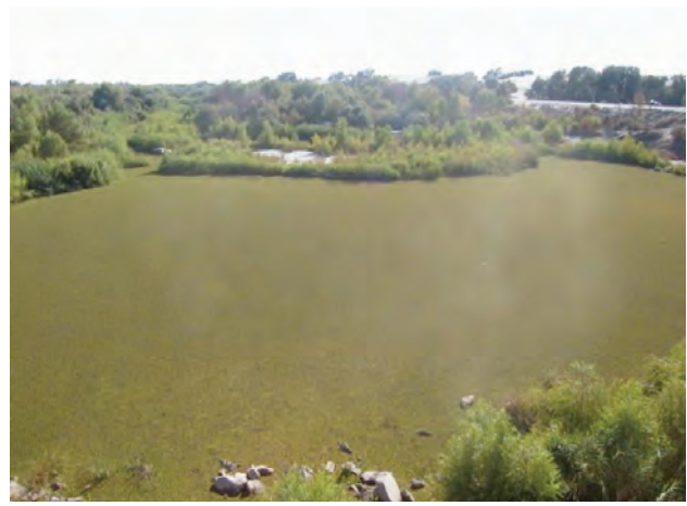
Aguas debajo de la presa Morelos.
