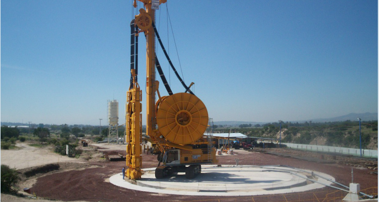
L20 muro milán, hidrofresa.
