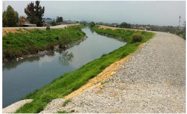
Relleno de grietas km. 3+000 (vista del desplazamiento de bordos)
