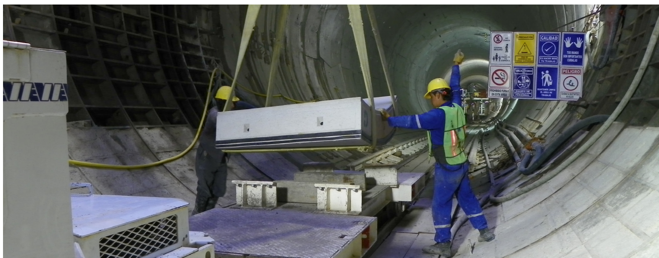
Dotación de dovelas al tramo en construcción.
