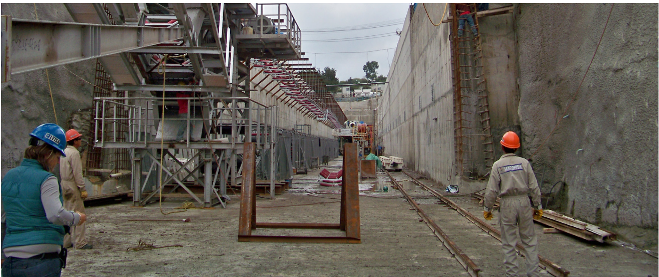
Portal de salida del TEO.
