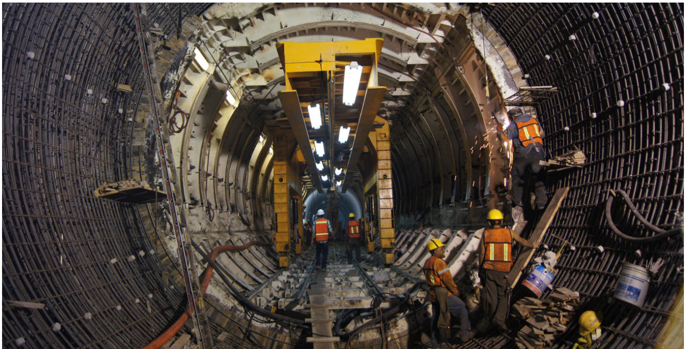
Cimbra metálica para colocar el revestimiento secundario del túnel.
