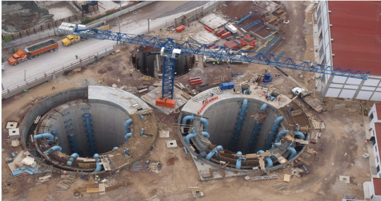
Construcción de la planta de bombeo El Caracol.
