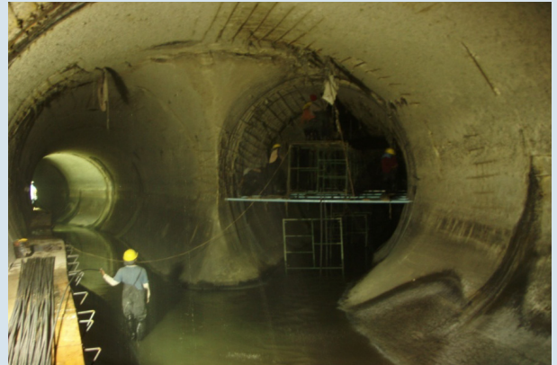
Inspección del Túnel Emisor Central.
