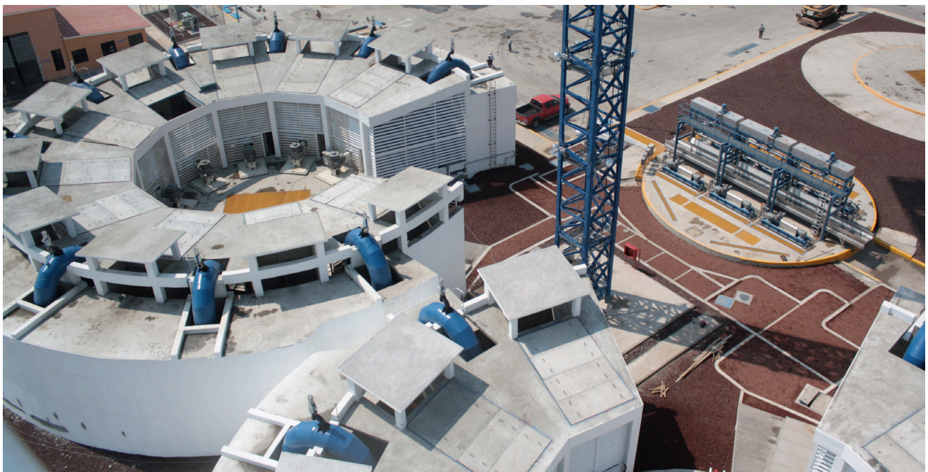
Vista de la planta de bombeo Casa Colorada Profunda.
