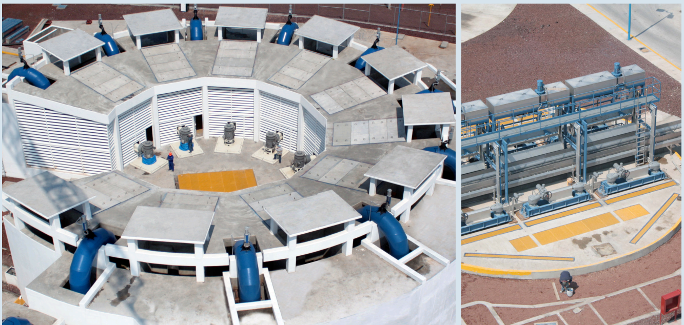
Planta de bombeo Casa Colorada Profunda.
