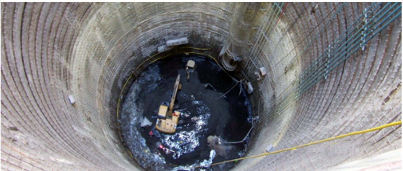
Lumbra 13 del Túnel Emisor Oriente.
