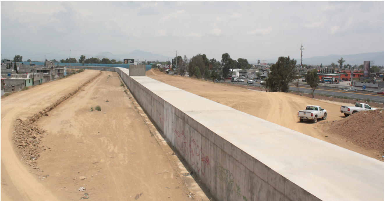
Construcción del colector sanitario Ducto de Estiaje del Canal Río de la Compañía.
