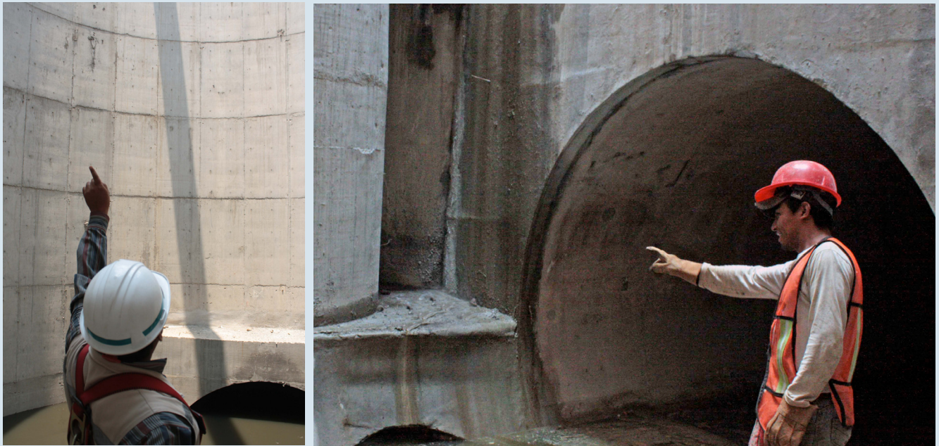
Túnel Interceptor Río de los Remedios.
