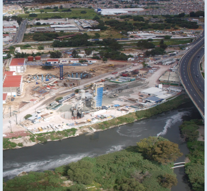
Planta de bombeo El Caracol.
