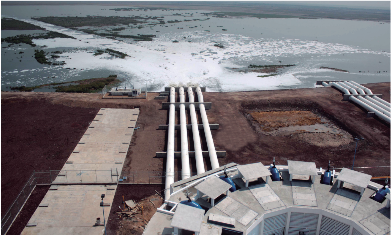
Descarga a la Laguna de Regulación Casa Colorada.
