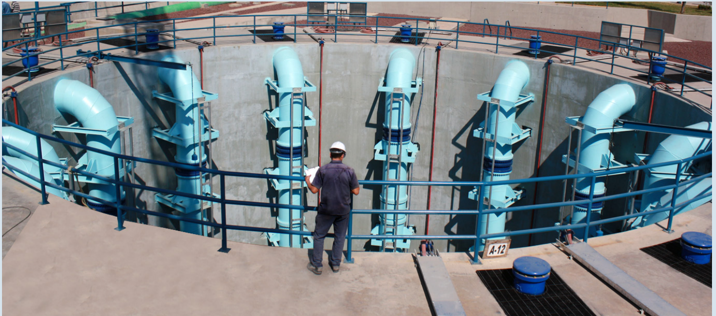
Planta de bombeo La Caldera.
