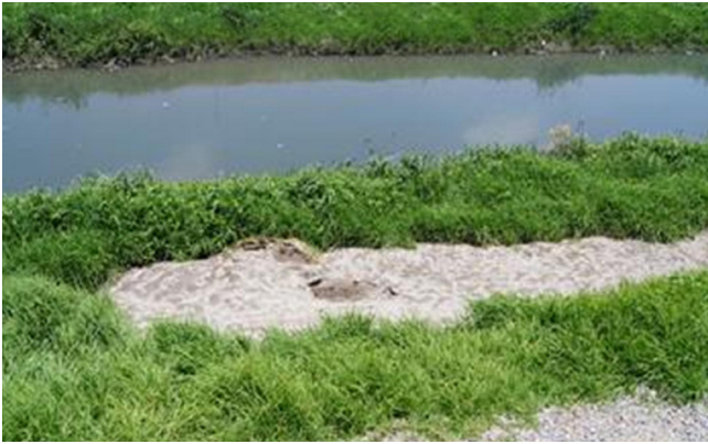
Relleno de grietas km. 3+150
