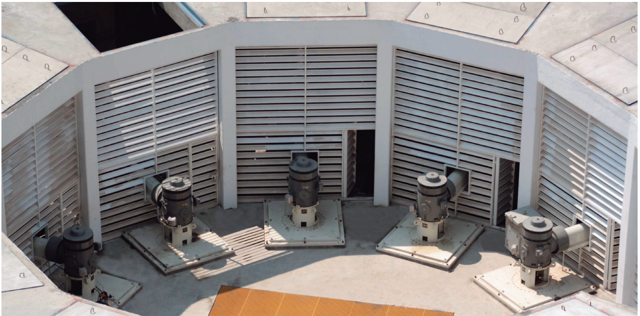
Bombas de la planta de bombeo Casa Colorada Profunda.
