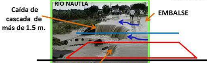
RÍO NAUTLA Caída de cascada de más de 1.5 m. EMBALSE DESBORDAMIENTO SOBRE CARRETERA FEDERAL 129, Km. 80 TERRAPLEN ELEVADO + 2.00 m.
