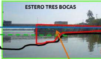
ESTERO TRES BOCAS PUENTE CASITAS, TERRAPLEN MIXTO BLOQUEA 30 m. DEL CAUCE + ARROYADA DERECHA
