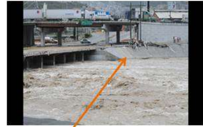
APROCHE PUENTE EN MONTERREY, TERRAPLEN DE RELLENO
