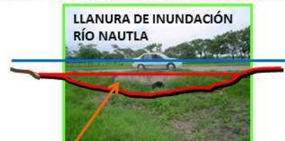
LLANURA DE INUNDACIÓN RÍO NAUTLA CAMINO RURAL EN "CALLE GRANDE" TERRAPLEN DE RELLENO SOBRE MICRO CUENCA
