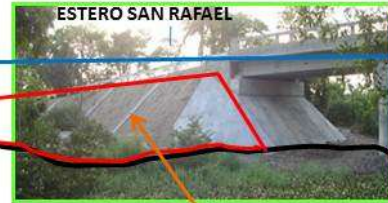
ESTERO SAN RAFAEL PUENTE TRES ESTEROS, TERRAPLEN DE RELLENO OBSTRUYE 50 % DE LA CUENCA, AFECTARA A 10,000 HABITANTES.
