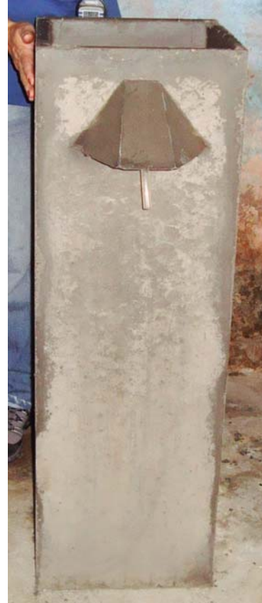
Ilustración 2. Construcción del filtro en la vivienda seleccionada.
