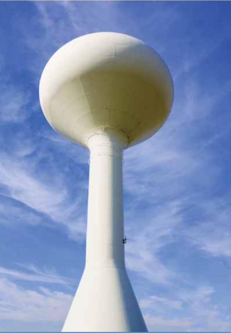
La torre de agua almacena agua potable limpia
