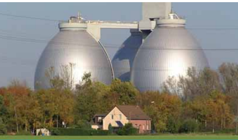
Tanques de digestión anaeróbica, planta de tratamiento de aguas residuales «Emschermündung» (Alemania)
