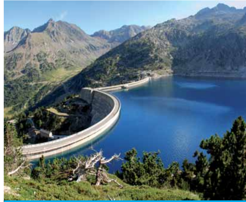
Depósito de agua del lago Cap-de-Long (Francia)
