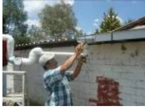
Figura 4. Instalación de Captación de Lluvia.
