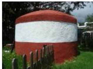
Figura 5. Cisterna instalada en vivienda.
