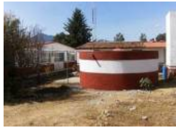
Figura 8. Captación y almacenamiento de agua de lluvia en comunidad de Quiroga.
