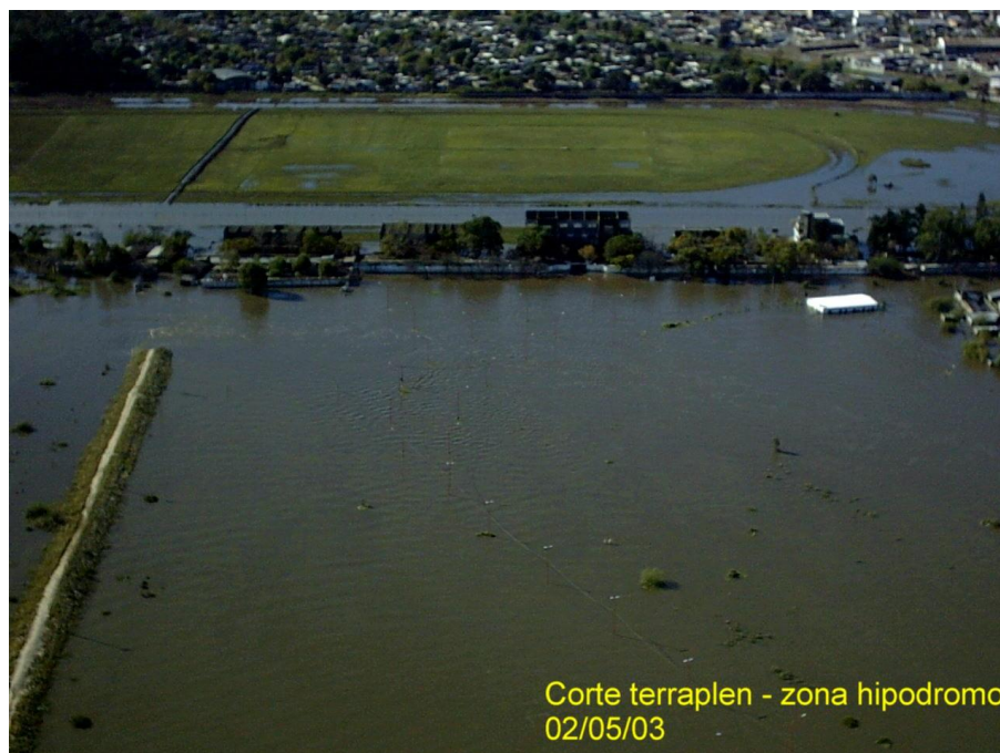
Foto 4.1. Corte del terraplén de protección lateral en la zona del hipódromo, ciudad de Santa Fe. Estado de situación al día 02/05/03.
