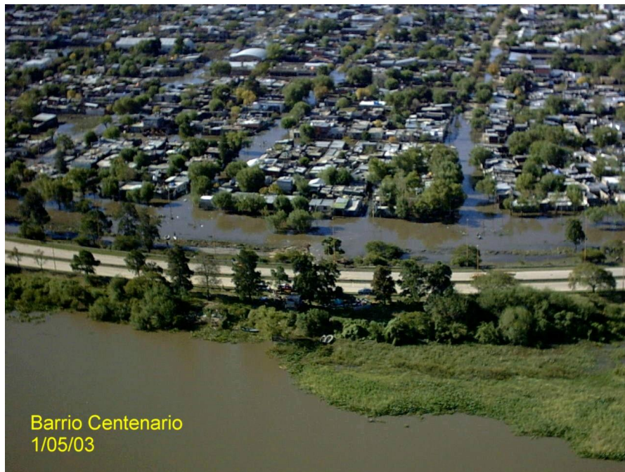
Foto 4.3. Barrio Centenario (extremo Sur-Oeste de la ciudad de Santa Fe). Estado de situación al día 01/05/03.
