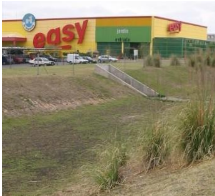
Foto 5.7. Cuenco de detención ejecutado en un emprendimiento comercial privado.
