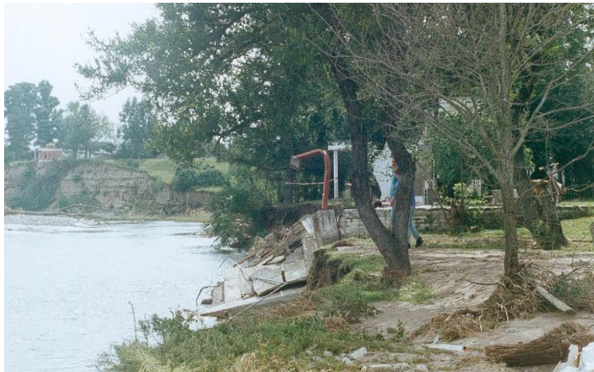
Foto 8.1. Destrucción de viviendas costeras. Márgenes del río Anizacate (Córdoba).
