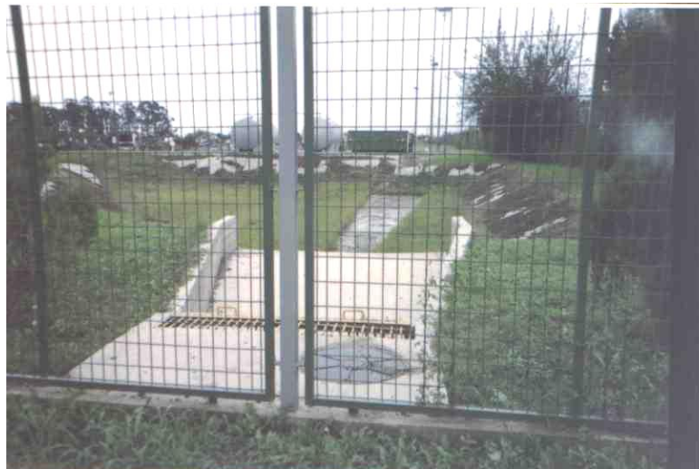
Foto 5.6. Cuenco de detención ejecutado en un emprendimiento privado. (Fuente: Toya et al., 2003).
