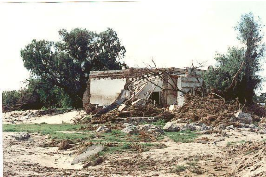
Foto 9.4. Daños sobre viviendas. Evento del 06/01/92 en S. C. Minas.
