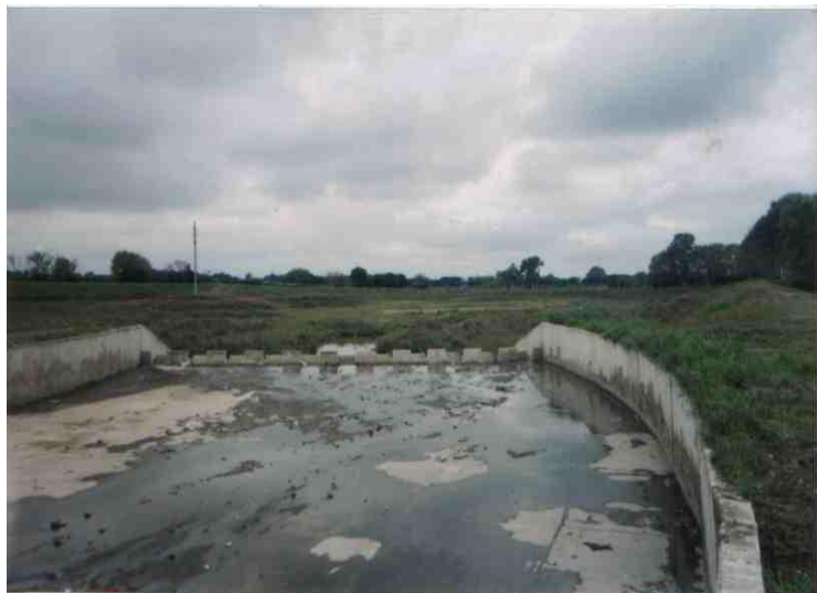
Foto 5.8. Cuenco de detención de grandes dimensiones ejecutado en un sector público.
