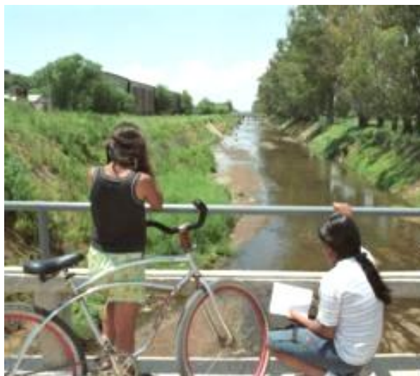
Figura 9.7. Aspecto del arroyo Cañada de Gómez, Pcia. de Santa Fe
