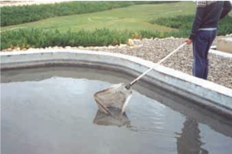
Foto 5.15. Limpieza de flotantes en la superficie de la Laguna Anaerobia.
