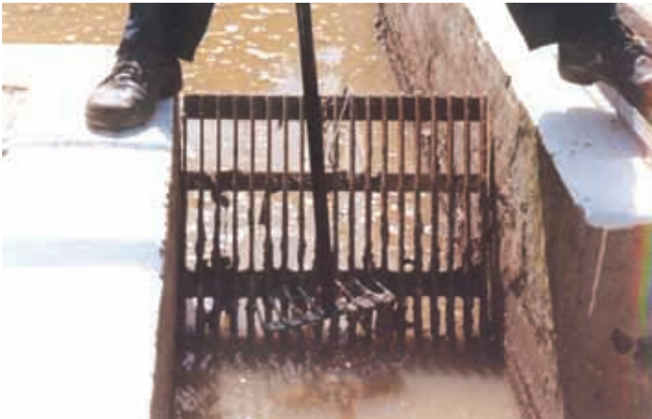
Foto 5.3. Limpieza manual de las rejas de desbaste.
