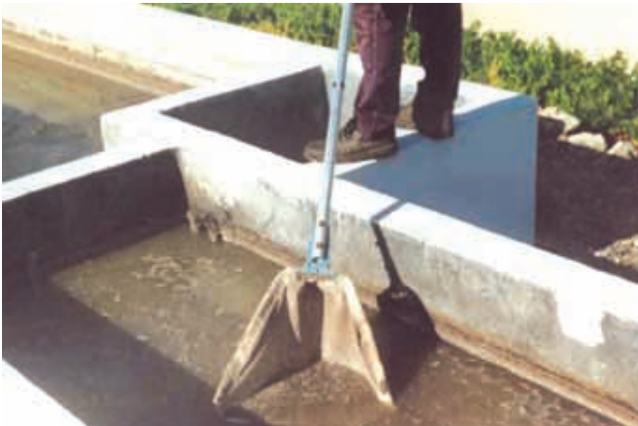
Foto 5.5. Extracción de grasas en el Desengrasador.
