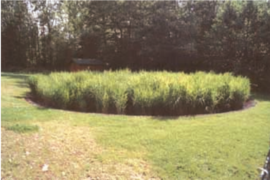
Foto 5.10. Humedal Artificial de Flujo Subsuperficial Vertical. PECC.
