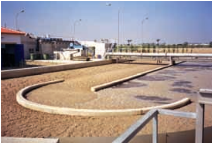
Foto 5.21. Reactor Biológico. EDAR de El Rocío (Huelva).
