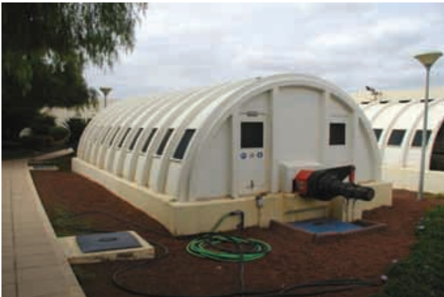
Foto 5.19. Contactor Biológico Rotativo. EDAR AENA Arrecife (Lanzarote - Las Palmas).
