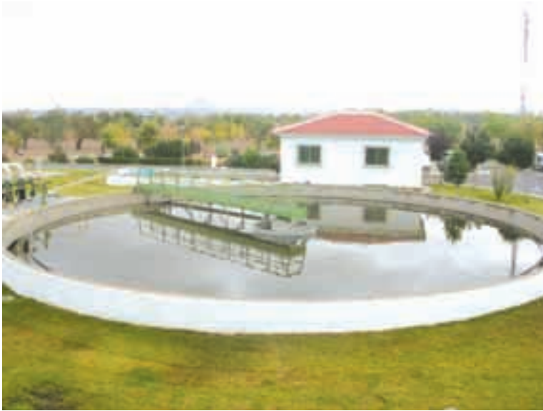
Foto 5.8. Decantador Primario. EDAR de Baza (Granada).
