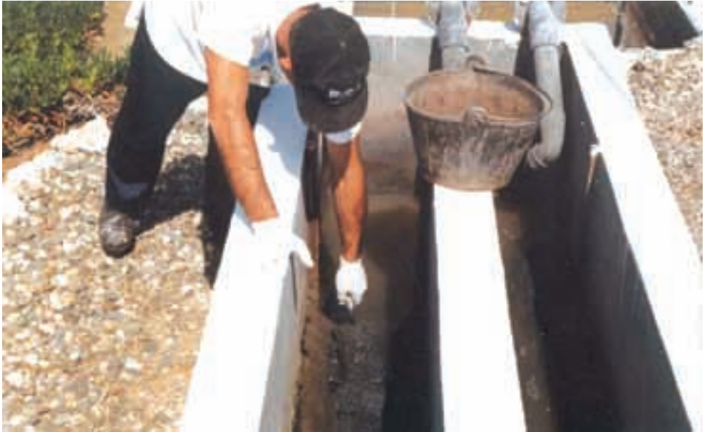
Foto 5.4. Limpieza manual de los canales desarenados. Evacuación de las arenas extraídas.
