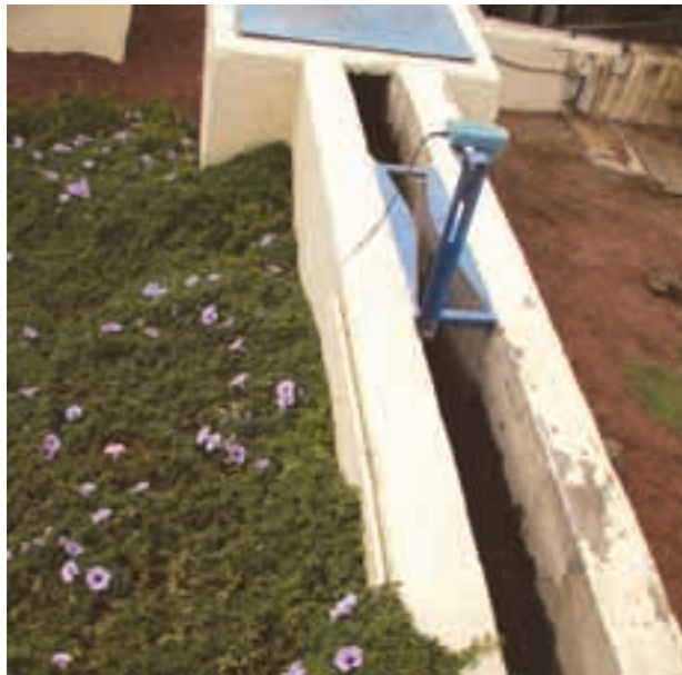
Foto 5.7. Canal Parshall. EDAR AENA Arrecife (Lanzarote - Las Palmas).
