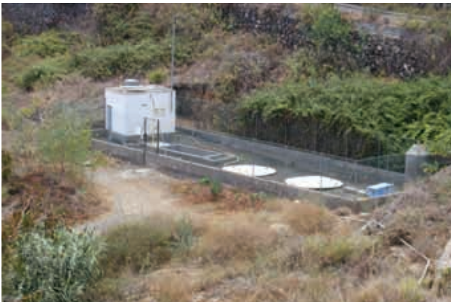
Foto 5.23. Planta compacta por Fangos Activados. EDAR Casa Aguilar (Gran Canaria - Las Palmas).
