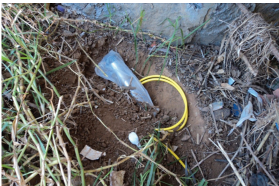
Figura 2. Dispositivo de registro de nivel (levellogger) GlobalWater instalado en Dren Tzurumútaro
