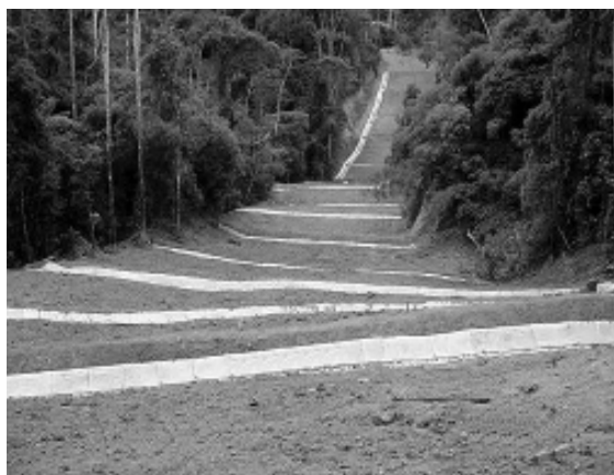
Fig. 39. Estabilización de pendientes.
