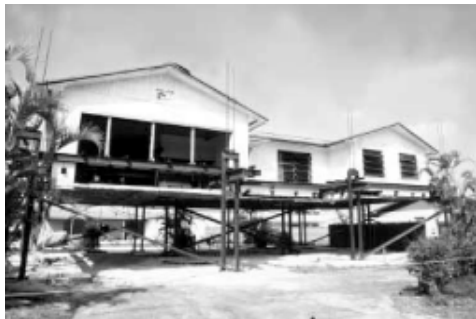
b) Baja Vulnerabilidad. El nivel del piso en la casa es más alto que el de la calle.
