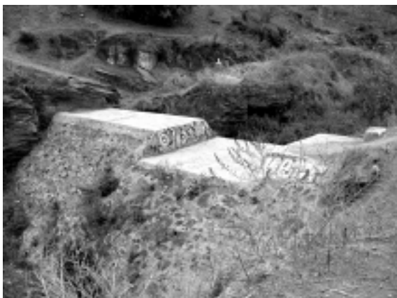
Fig. 38. Presa reguladora de avenidas (rompe-picos).
