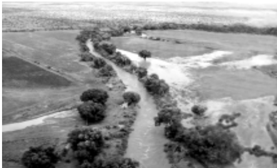
Fig. 27. Afectación en terrenos aledaños por desbordamiento de un río. Cortesía de la Unidad de Protección Civil en Zacatecas (septiembre de 2003).
