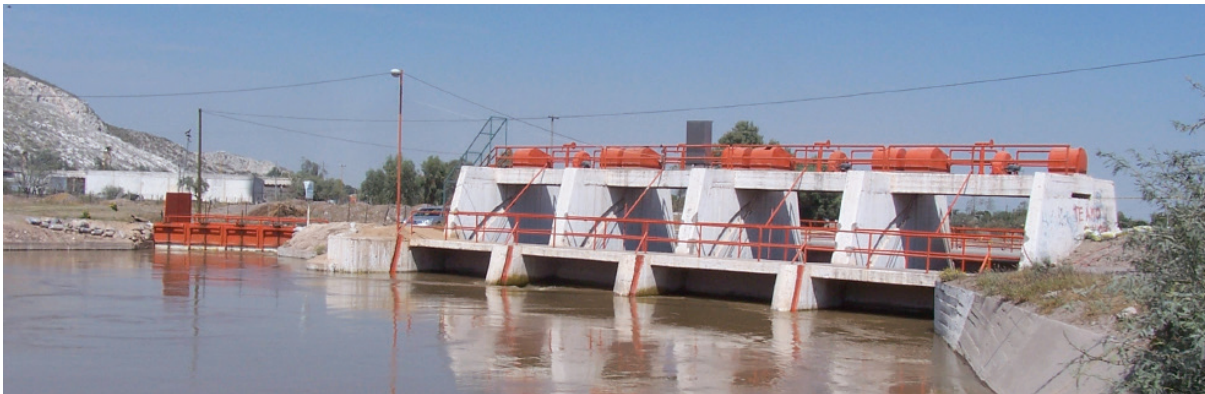
Figura 62. Derivadora San Fernando en funcionamiento. Las compuertas de la izquierda alimentan el canal Santa Rosa-Tlahualilo, y las compuertas de la derecha son la entrada del canal Sacramento.
