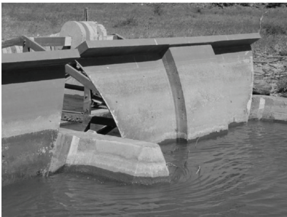
Figura 77. Compuerta AMIL metálica. DR 053 Estado de Colima. Cortesía del Dr. Ariosto Aguilar Chávez.
