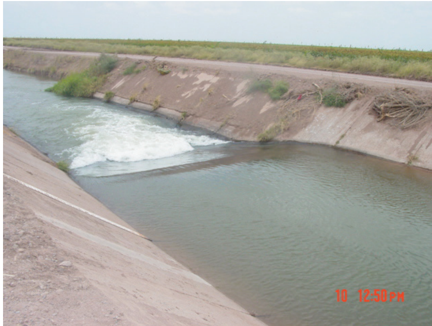
Figura 57. Aforador de garganta larga sin estrechamiento de las paredes. Cortesía Dr. Víctor M. Arroyo Correa.
