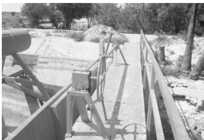
Figura 90. Compuerta aligerada del canal Rode. Nótese el volante para mover el malacate, y el candado para disminuir el vandalismo.
