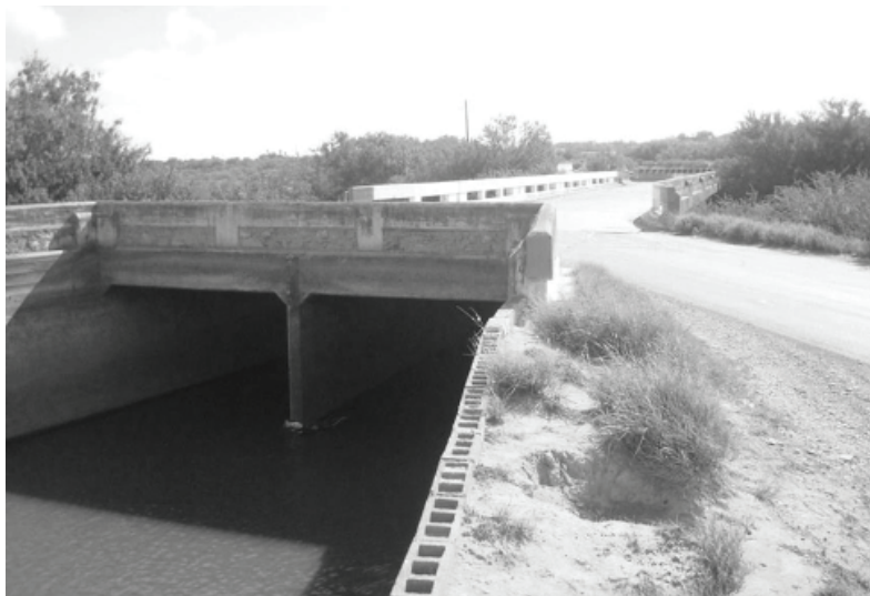
Figura 93. Puente canal vehicular del Km 6+700 del canal Rode, con dos cajones o ductos para 60.0 m 3 /s de capacidad, para cruzar el arroyo San Pedro y uso vehicular de la carretera Comales-Camargo. DR 026 Bajo Río San Juan, Tam.
