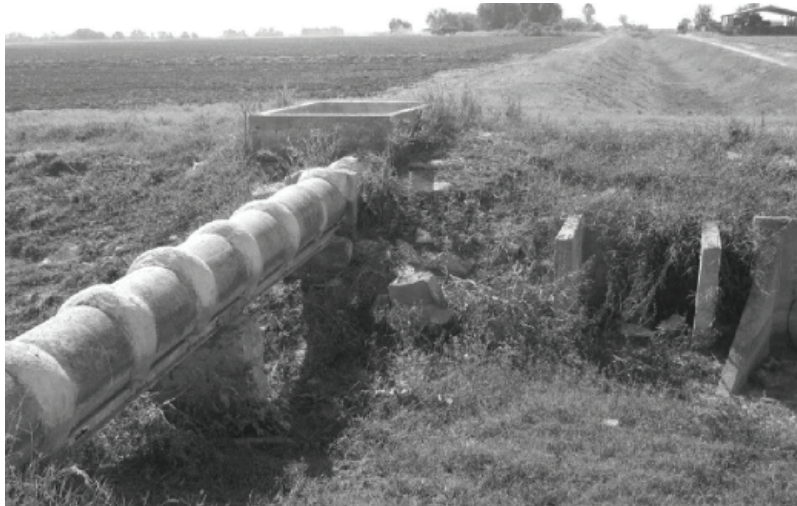
Figura 94. Puente canal de tubería de concreto de 24", de 150 lps de capacidad, para cruzar un canal cuyo claro es de 10 m, ubicado en el módulo III-4 del DR 025 Bajo Río Bravo, Tam.
