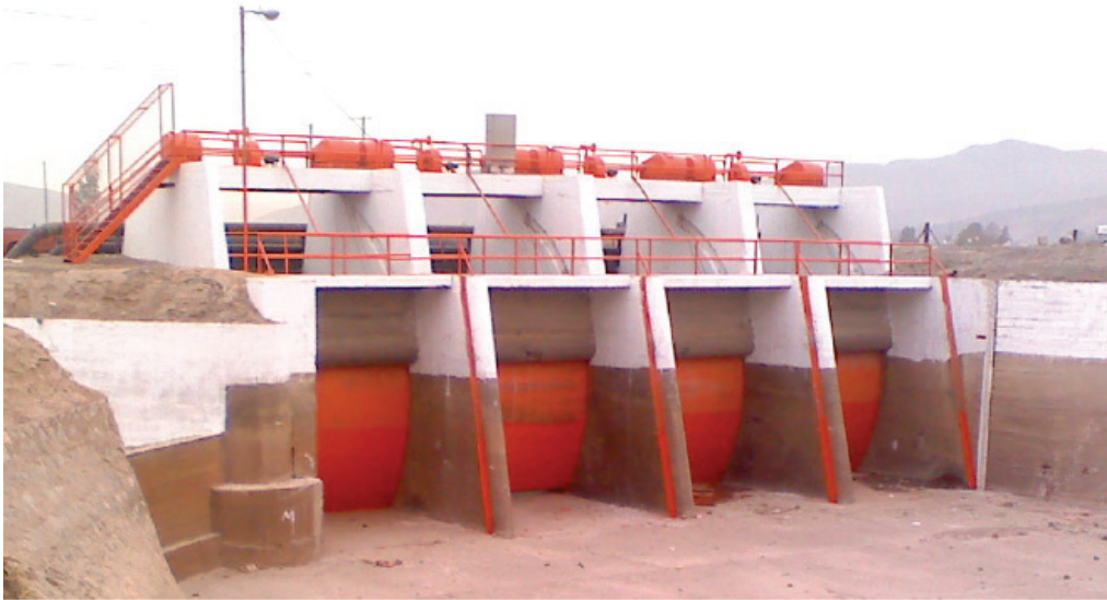
Figura 61. Derivadora San Fernando en el río Nazas, Distrito de Riego 017 Región Lagunera. Cortesía de Takarai, Cd. Lerdo, Durango.
