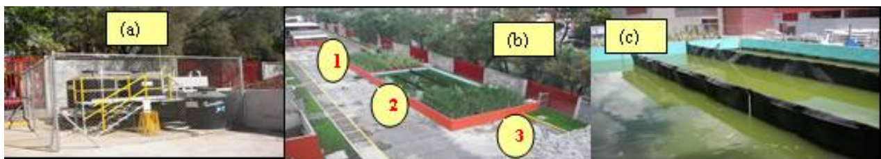
Figura 1: Sistema Humedal-laguna-humedal en la UAM-Azcapotzalco: a) Sistema de pretratamiento para lodos, primer humedal, laguna segundo humedal. Laguna de maduración entre los dos humedales
