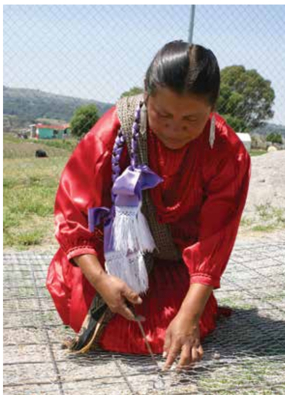
Fig. 2.67 Trabajo en el tejido de la malla para una cisterna de ferrocemento.
