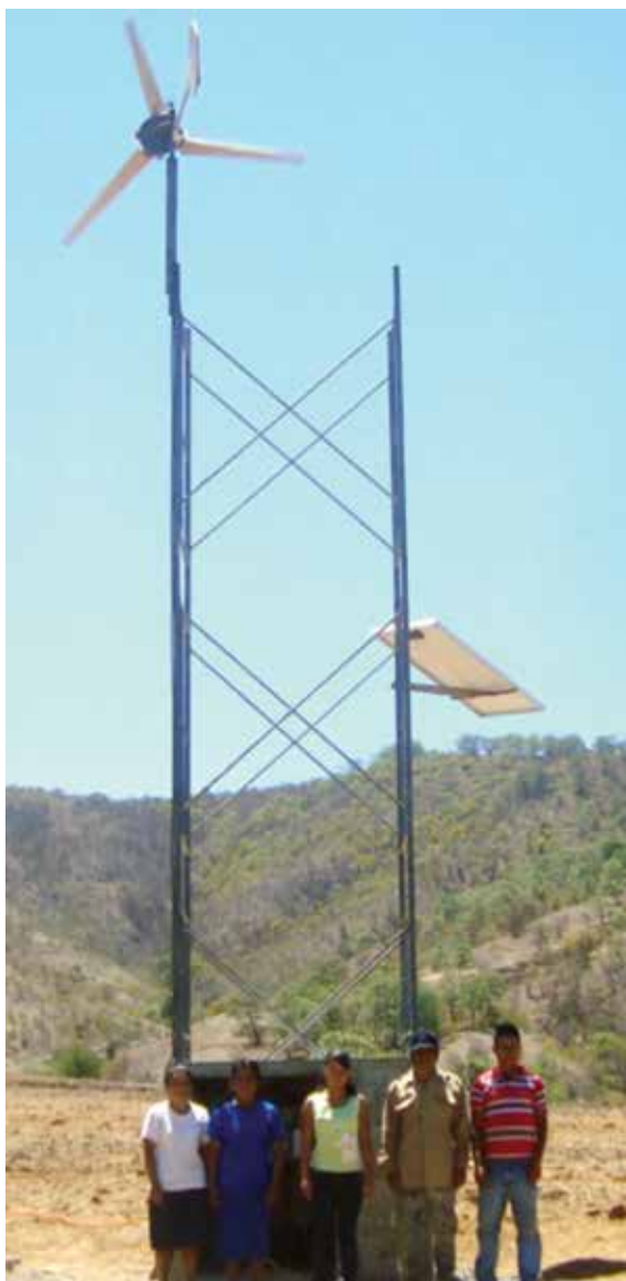
Fig. 2.24 Sistema autónomo híbrido (eólico-solar). Fotografía cortesía de GRUPEDSAC.
