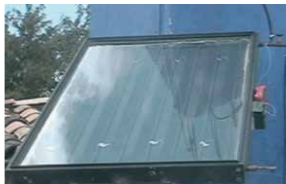
Fig. 2.36 Calentador solar de colectores planos. Fotografía cortesía de Universidad Autónoma de Aguascalientes.
