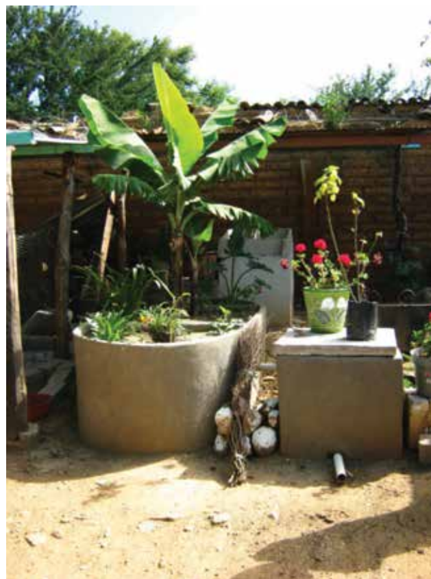
Fig. 2.44 Biofiltro implementado por GRUPEDSAC. Fotografía cortesía de GRUPEDSAC.
