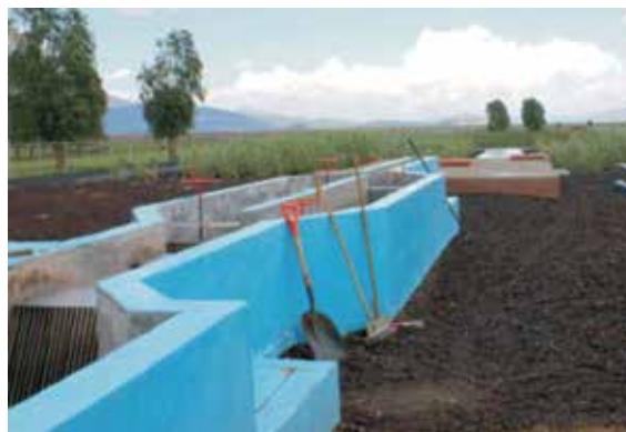
Fig. 2.47 Humedal para el tratamiento de las aguas residuales de Erongarícuaro, Michoacán.
