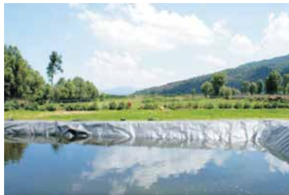
Fig. 2.46 Humedal para el tratamiento de las aguas residuales de la comunidad de Cucuchuco, Tzintzuntzan, Michoacán. Fotografía cortesía de IMTA.
