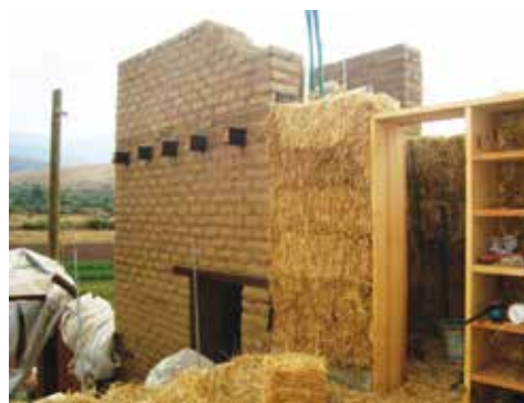
Fig. 2.64 Construcción con paja, madera y adobe. Fotografía cortesía de Eco-Constructores.
