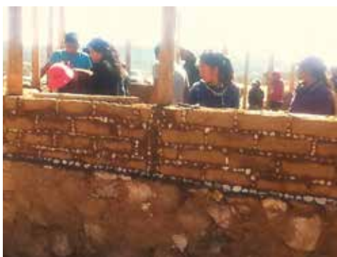
Fig. 2.62 Taller de construcción con adobe.
