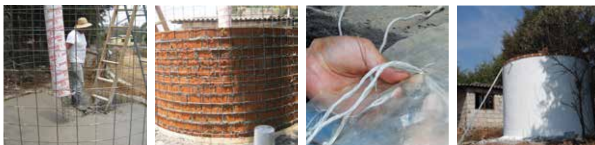
Fig. 2.40 Ejemplo de construcción de cisterna de ferrocemento.
