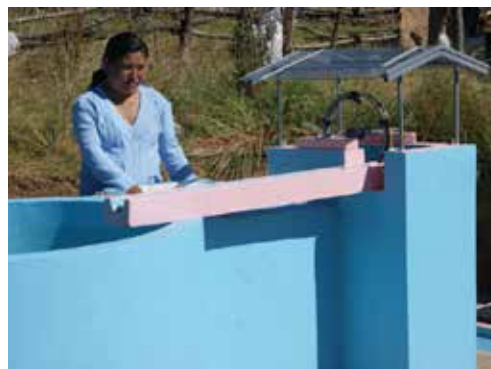
Fig. 2.69 Pileta para agua y bomba de mecate implementa por FpCVB.
