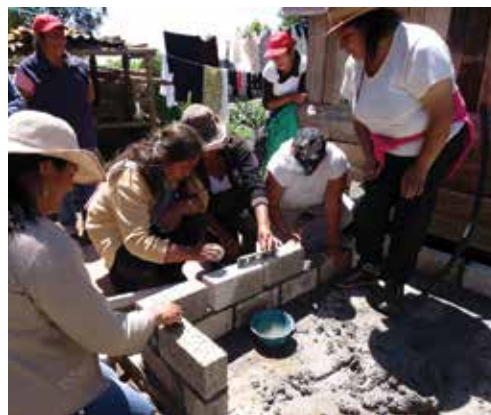
Fig. 2.70 Construcción de un sanitario ecológico seco.
