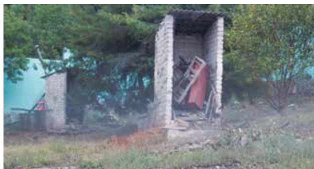
Fig. 2.51 Sanitarios abandonados en una escuela rural de Michoacán.
