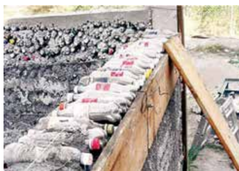
Fig. 2.65 Construcción con PET y paja. Fotografía cortesía de José de Jesús Pérez Bueno, CIDETEQ.
