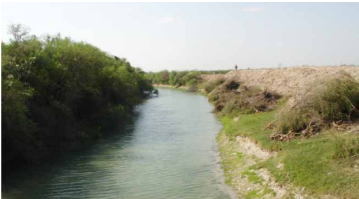
Uno de los aspectos de la actual infraestructura de riego del DR 004 Don Martín.
