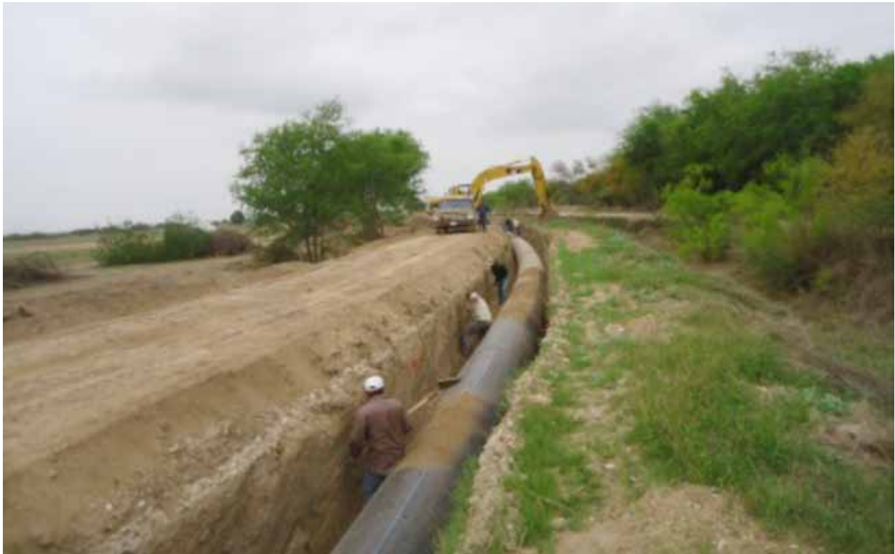
Obra de entubamiento para mejorar la eficiencia de conducción.
