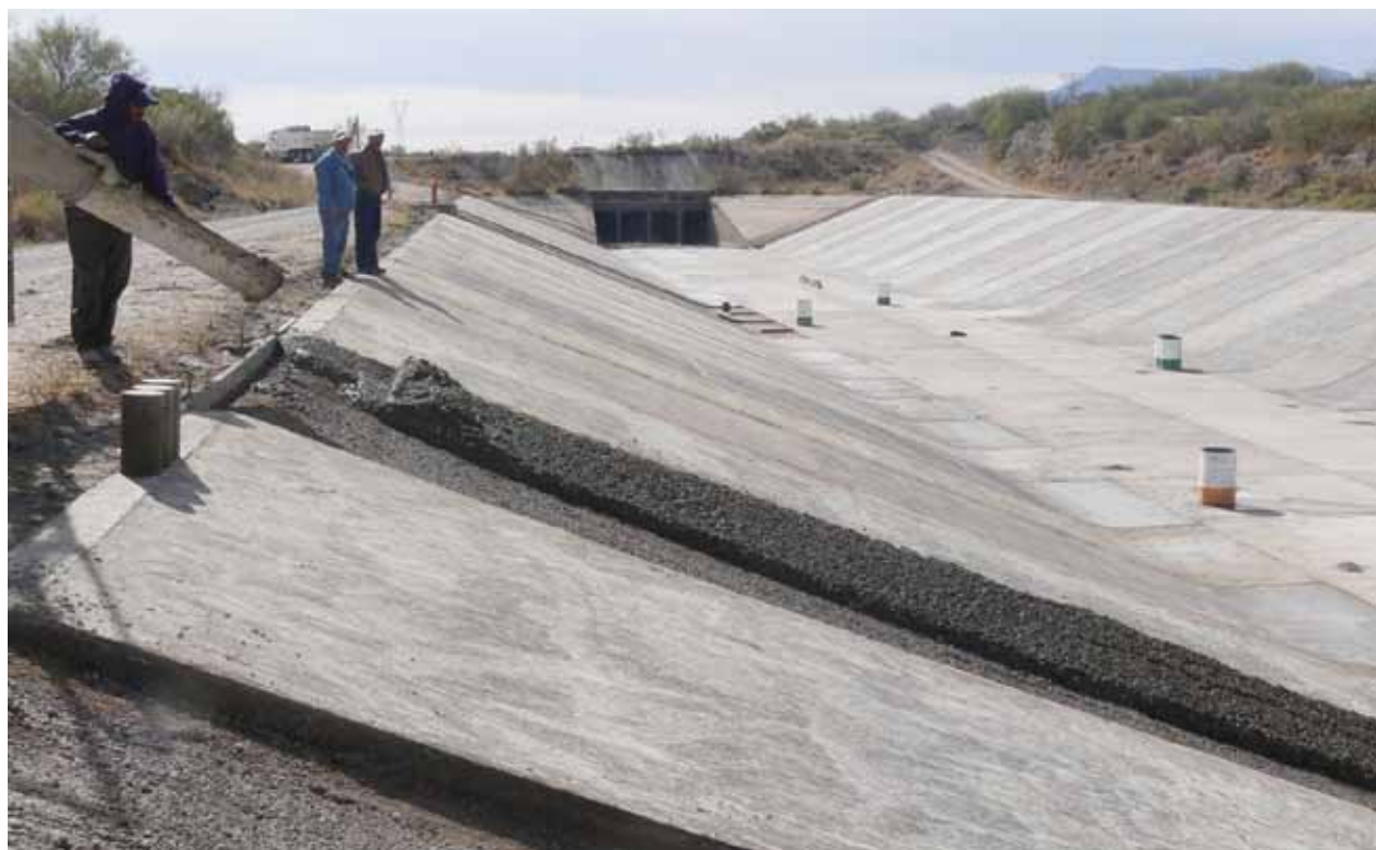
Revestimiento de canal.
