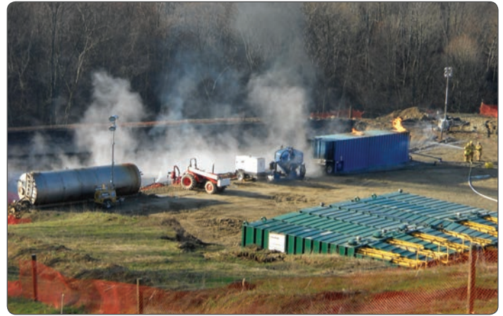
Combate del incendio producido en el liner (membrana de polietileno de alta densidad) de una pila de aguas residuales de fracking, en el pueblo de Hopewell, Pensilvania.
