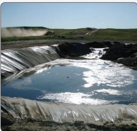
“Depósito de lodos residuales” en un sitio de perforación de gas de lutitas en Bakken, EE.UU.
