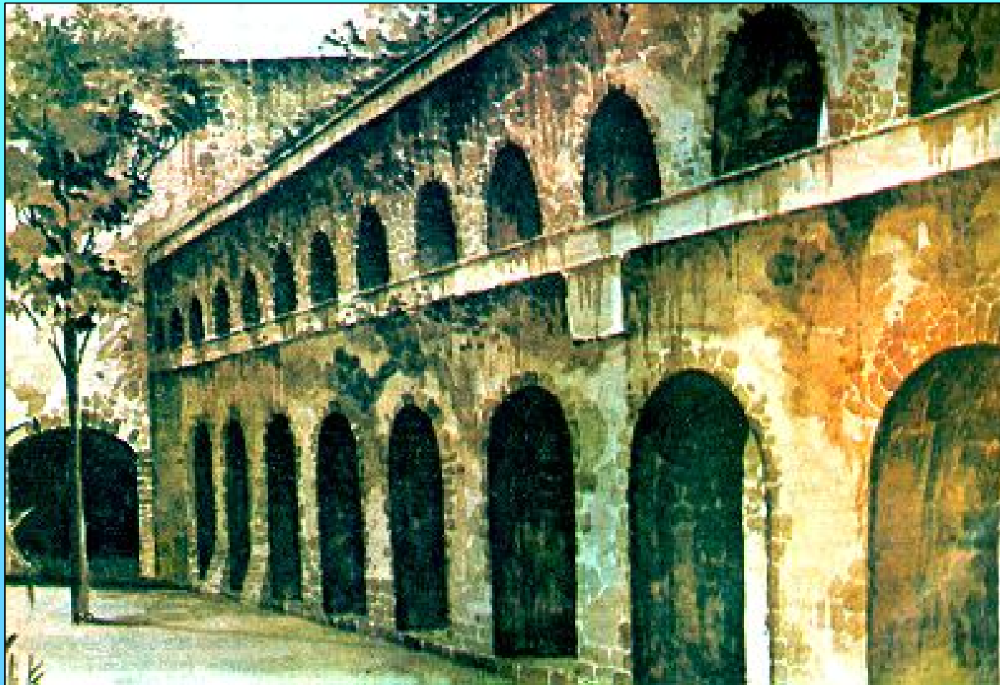
Acueducto de la Tlaxpana
