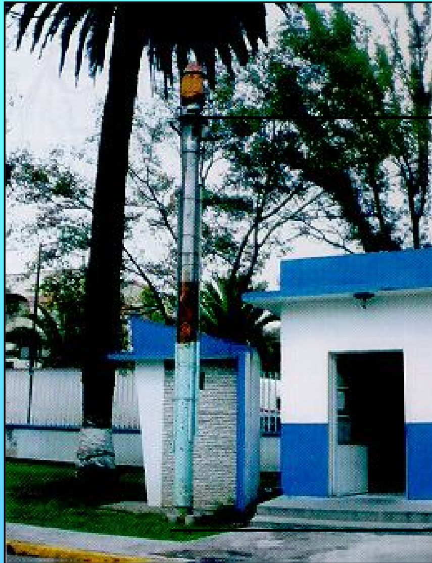
Hundimientos Diferenciales
