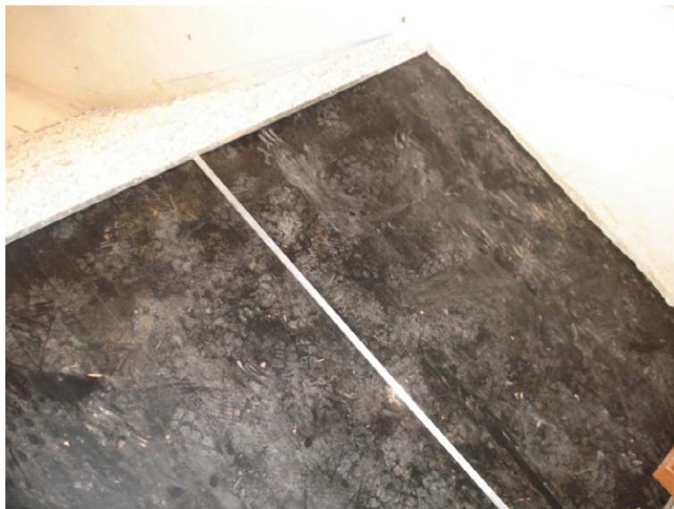
Foto 16. Pantalla impermeable de aguas arriba
