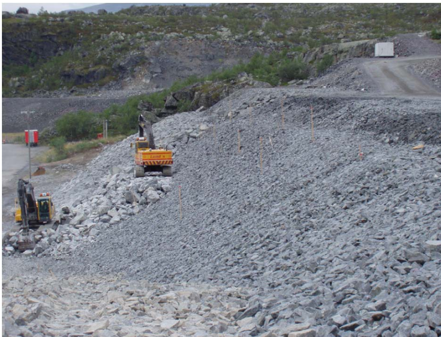
Foto 4. Construcci n de la protecci n en repi  de la presa de Suorva (Fuente: Nilsson 2004)
