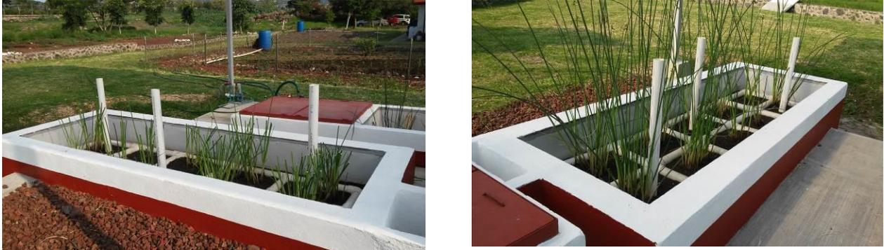
**Figura 2.** Sistema de distribución de agua residual y tuberías de aireación.
