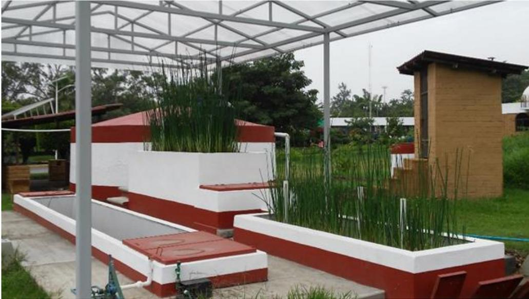
**Figura 1.** Modelo físico experimental de VSFCW.
