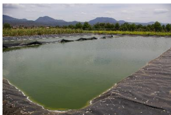
Tratamiento de aguas residuales mediante sistemas lagunares 24 horas
