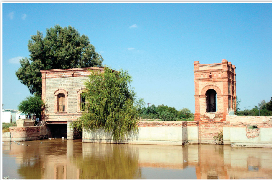
Compuertas de la presa de Guadalupe. También es conocida como presa Vida Nueva
