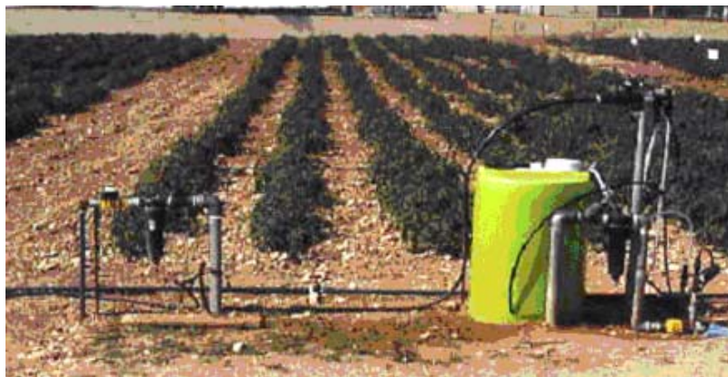
Figura 7.40. Equipo de regulación y control de un sector, incluyendo válvulas automáticas volumétricas, filtros, tanque de fertilizante, manómetros y regulador de caudal.
