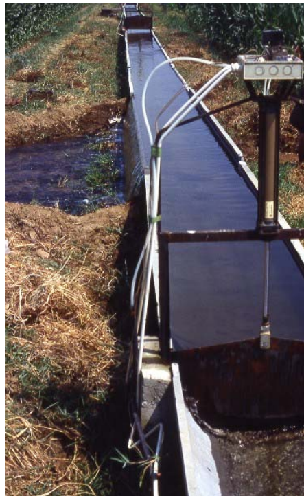
Figura 5.25. Canal con compuertas automatizadas y descarga lateral para la distribución del agua a los canteros.
