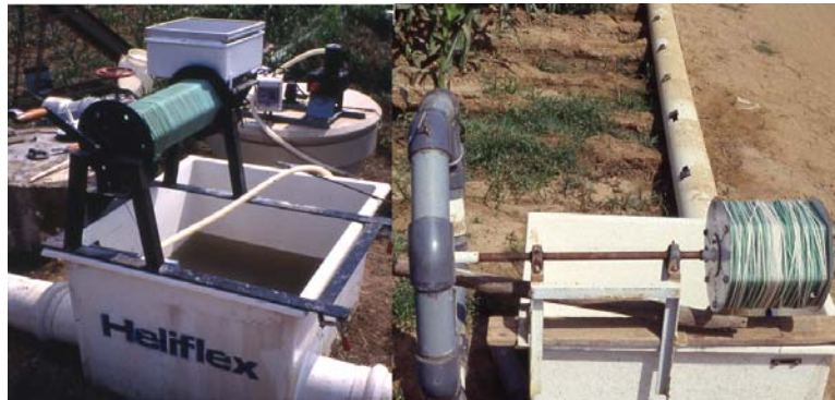
Figura 5.32. Sistemas de control de la velocidad de avance del cable y del tapón en los sistemas riego con cable para surcos: a la derecha, con regulación por rueda hidráulica, teniendo, por atrás, el depósito y el inyector de fertilizantes; a la izquierda, con motorización y comando electrónico.
