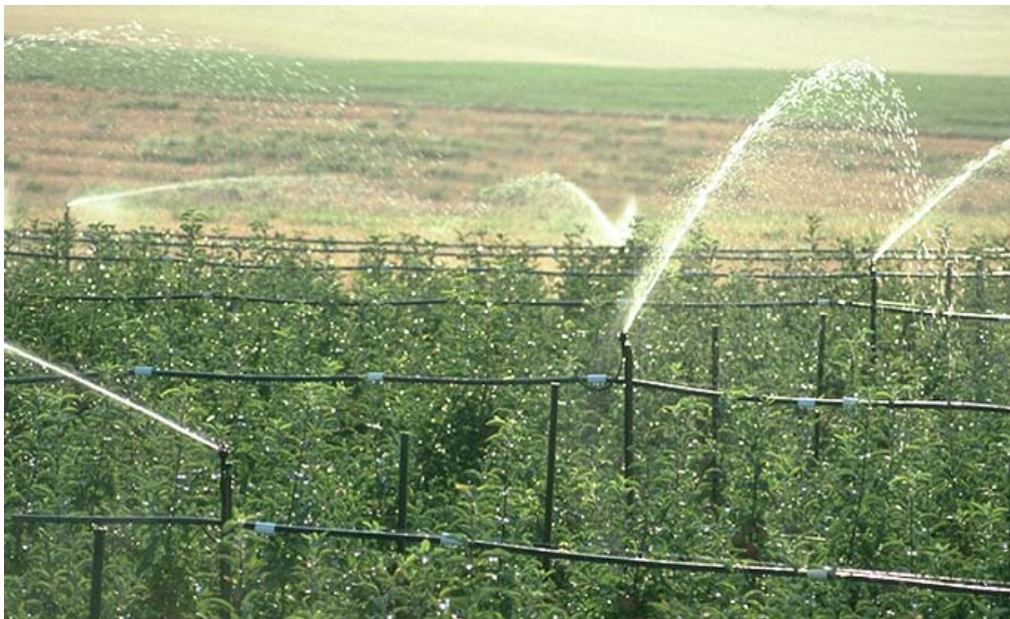
Figura 6.33. Instalación de un aspersor de impacto conectado a una tubería subterránea para proporcionar la rotación del aspersor en la horizontal y minimizar problemas en la unión a la tubería.
