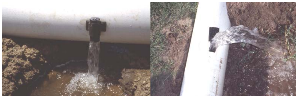
Figura 5.23. Tubos con compuertillas; a la derecha, con válvula corredera y a la izquierda, con válvula de rosca, regulables.
