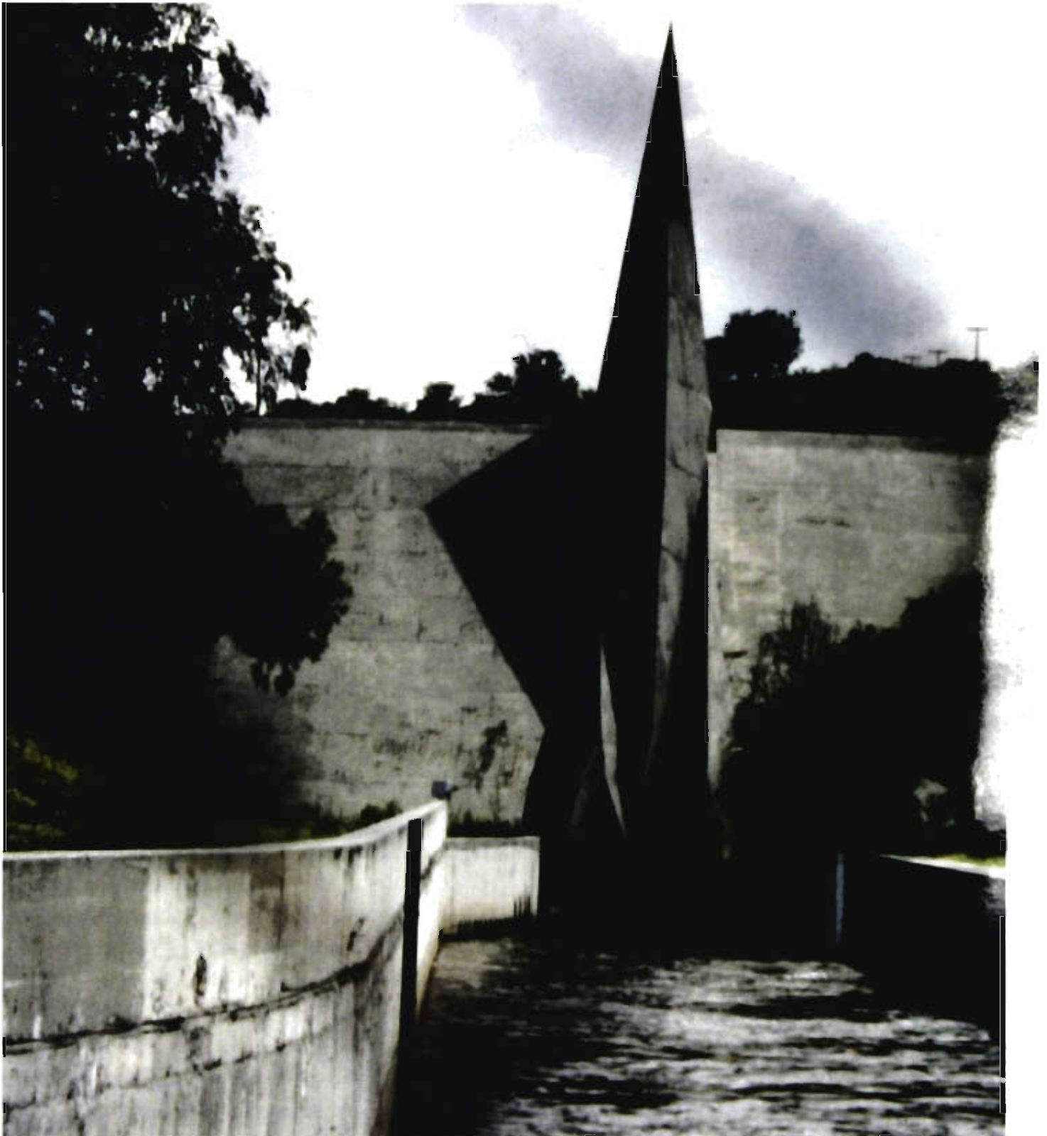
Portal de salida del emisor central del Drenaje Profundo, 2006. Es el mayor de los cuatro conductos de salida de las aguas residuales y pluviales desalojadas, vía el río Tula, hacia los distritos de riego con agua negra en el estado de Hidalgo.
