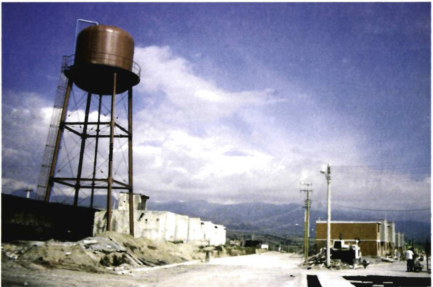
Pozo de agua potable aledaño al fraccionamiento San Buenaventura; al lado se aprecia la cisterna de almacenamiento. Como en muchos otros fraccionamientos de las periferias metropolitanas, la extracción se hace entre los 250 y 400 metros de profundidad.
