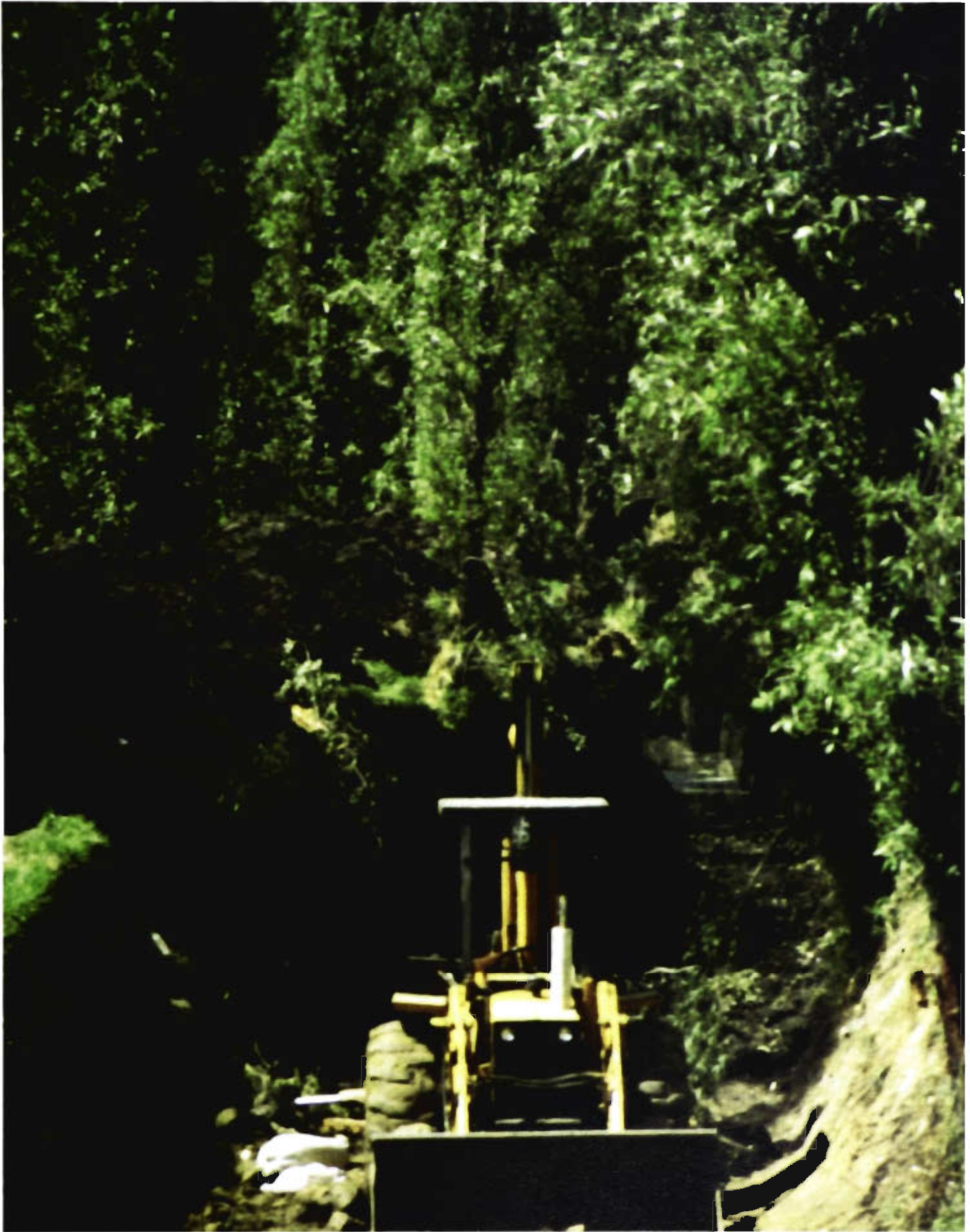
Producto de la excesiva extracción del acuífero y el consecuente hundimiento del suelo, el agua de los canales tiende a desaparecer, obligando a excavar permanentemente los canales.
