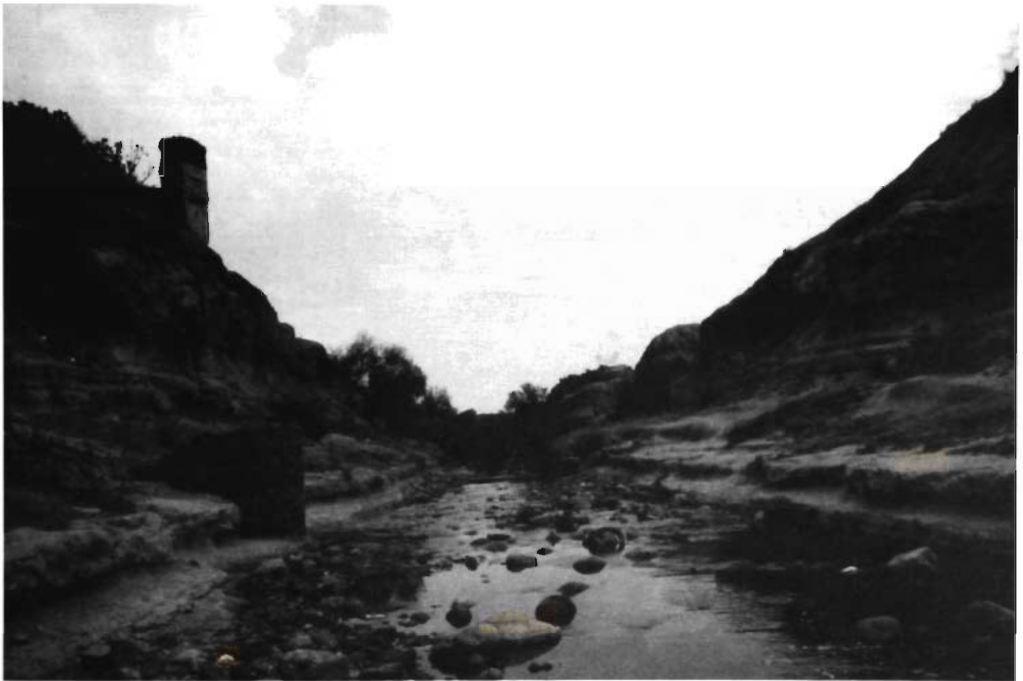
El Tajo de Nochistongo, 2006. A la izquierda se conservan aún restos de la edificación de la colosal obra por donde todavía hoy desembocan las aguas negras y pluviales de la ciudad de México hacia el Golfo de México.
