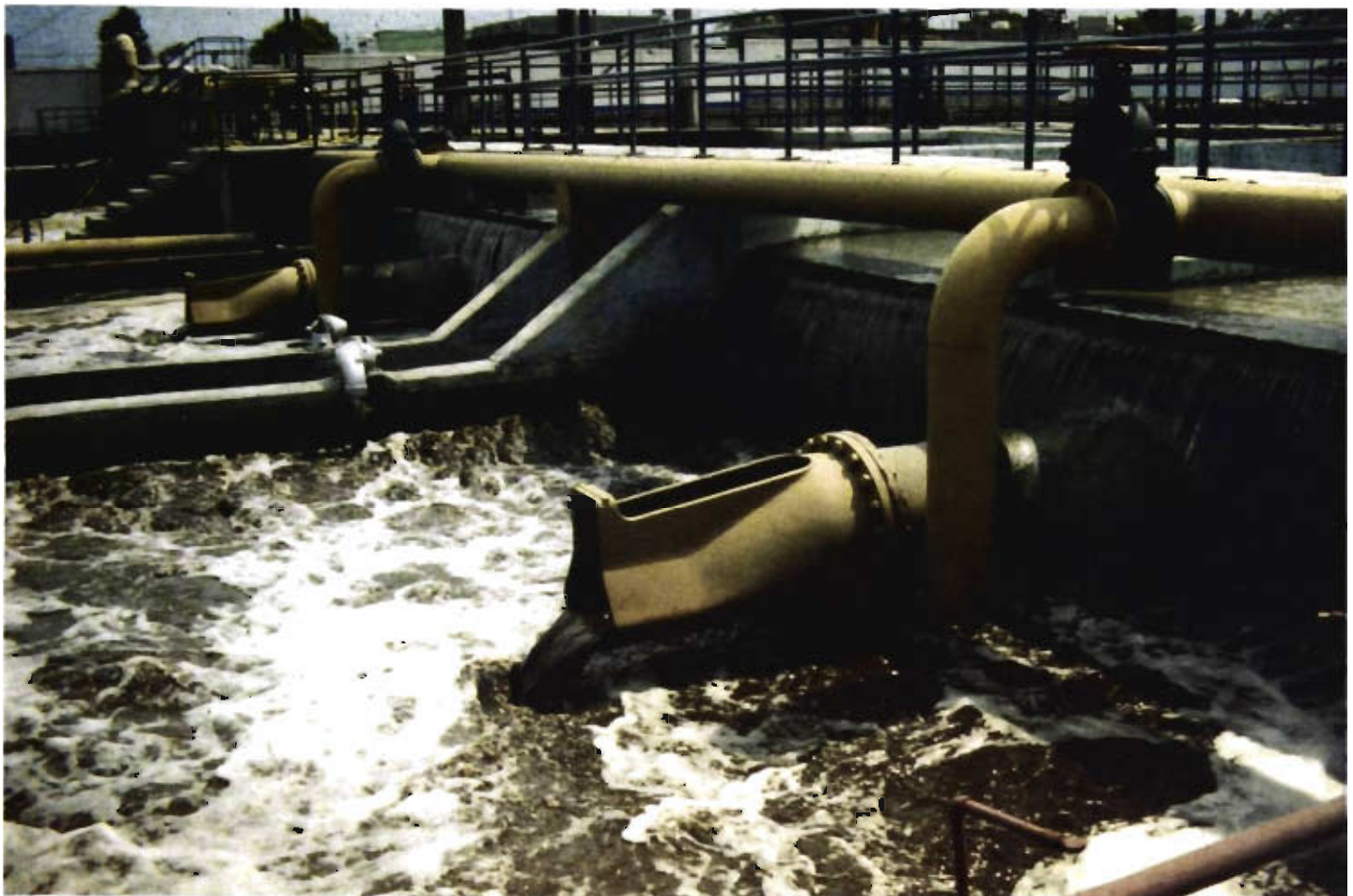
Planta de tratamiento de agua Cerro de la Estrella, 2004. El agua tratada, de nivel terciario o casi potable, es enviada en gran parte a los canales de Xochimilco y San Gregorio Atlapulco.
