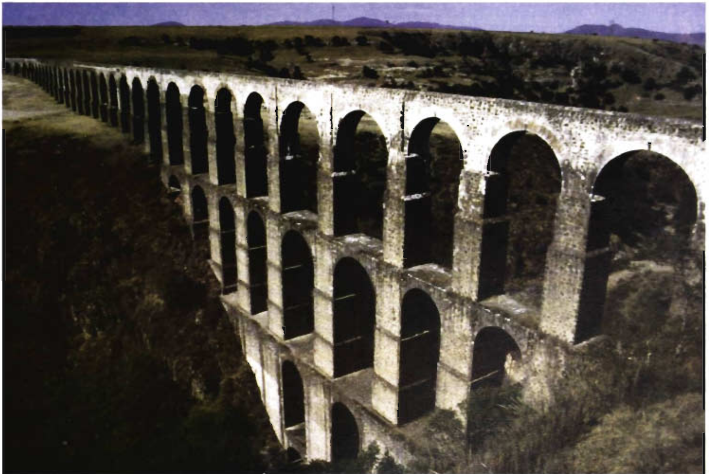
Acueducto llamado de los Arcos, en las cercanías de Tepozotlán; todavía hasta los primeros años del siglo XX distribuía agua procedente de los manantiales y ríos de las sierras del poniente hasta Tepozotán y algunos pueblos aledaños.
