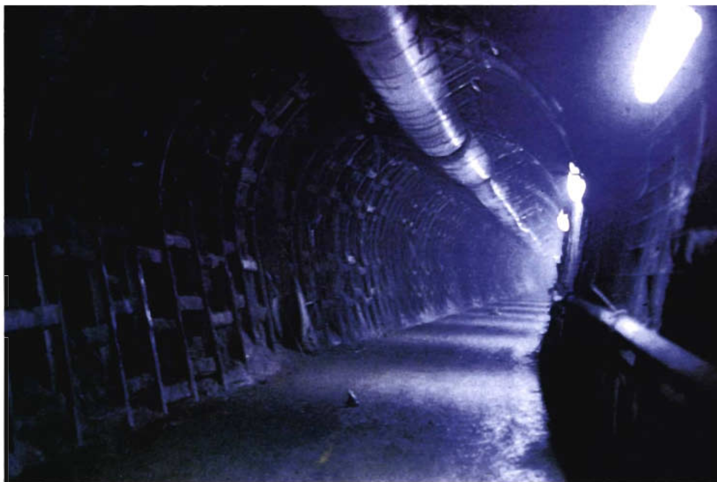
El túnel del Acuaférico de cinco metros de diámetro cavado en roca a noventa metros de profundidad; sus paredes se hayan reforzadas en su revestimiento para soporrar el paso de 25 metros cúbicos por segundo.
