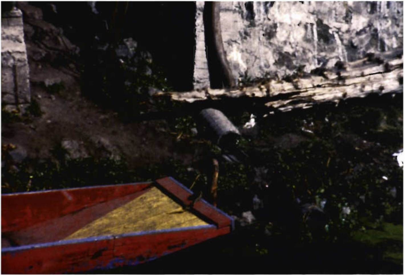
Descargas residuales de las viviendas sin tratamiento alguno directamente a los canales chinamperos; una práctica cotidiana que debe ser atendida urgentemente con sistemas y tecnologías adecuadas, sin importar su costo.
