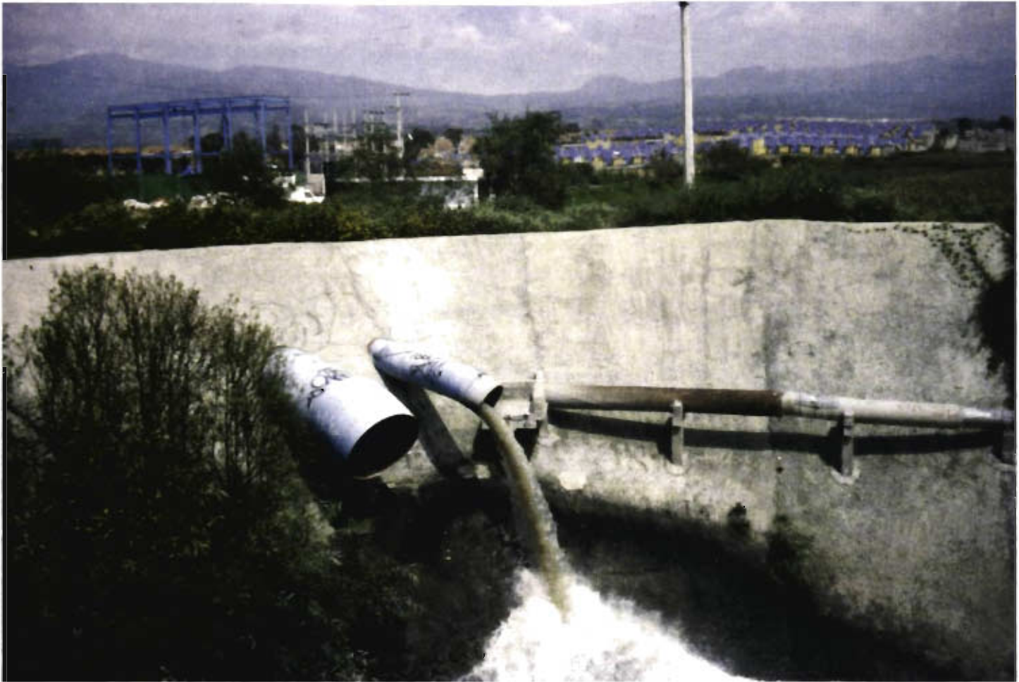
Descargas residuales del fraccionamiento San Buenaventura hacia el río San Francisco, afluente del drenaje llamado Canal de la Compañía. El agua, que se descarga sin tratamiento alguno, será a mediano plazo causa de la saturación de dicho drenaje.
