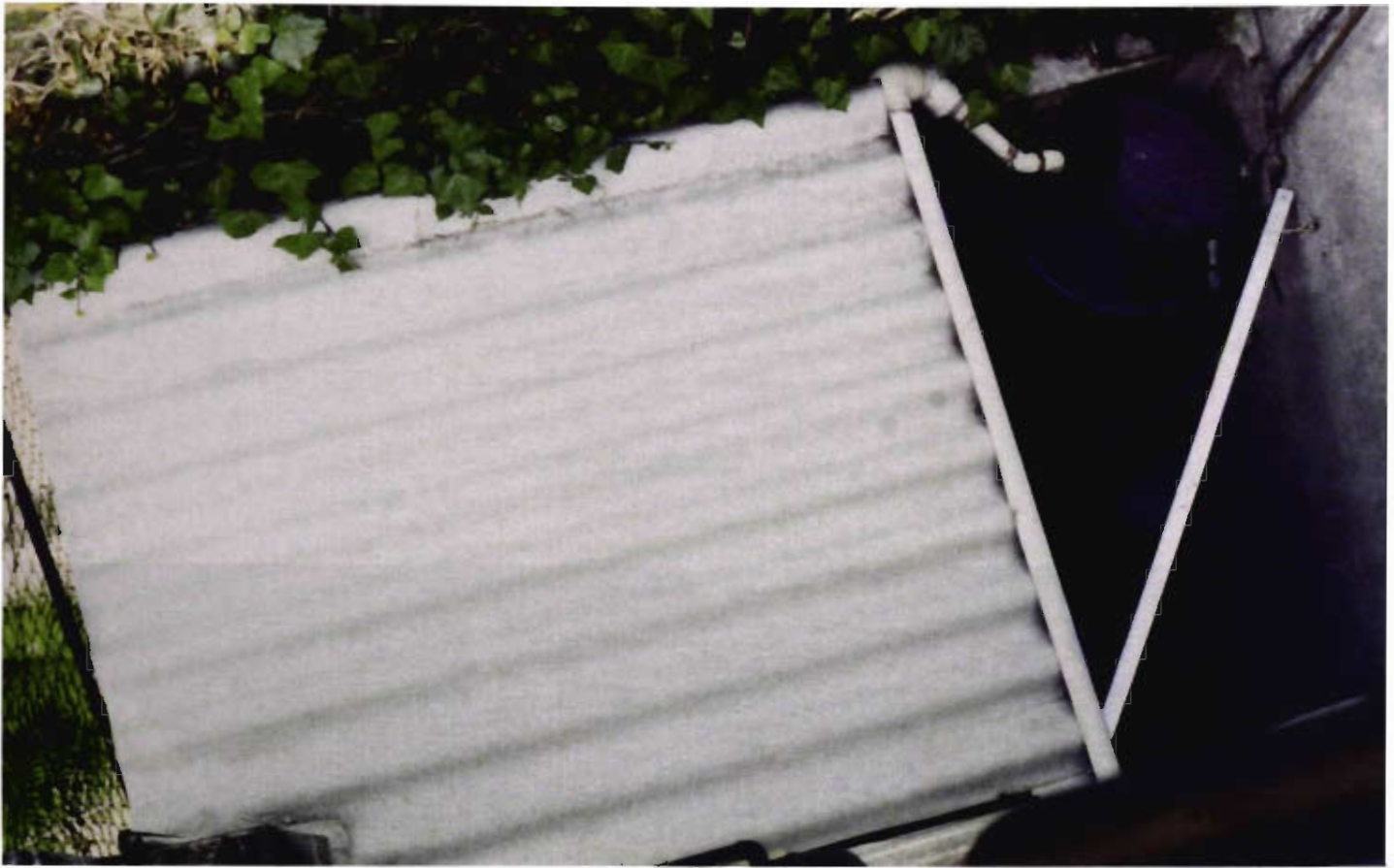
Captación doméstica de agua de lluvia, Yautepec, 33, Condesa, 2006. El agua es almacenada, mediante una canaleta, en un tambo; de ahí es canalizada hacia todos los baños de la vivienda.
