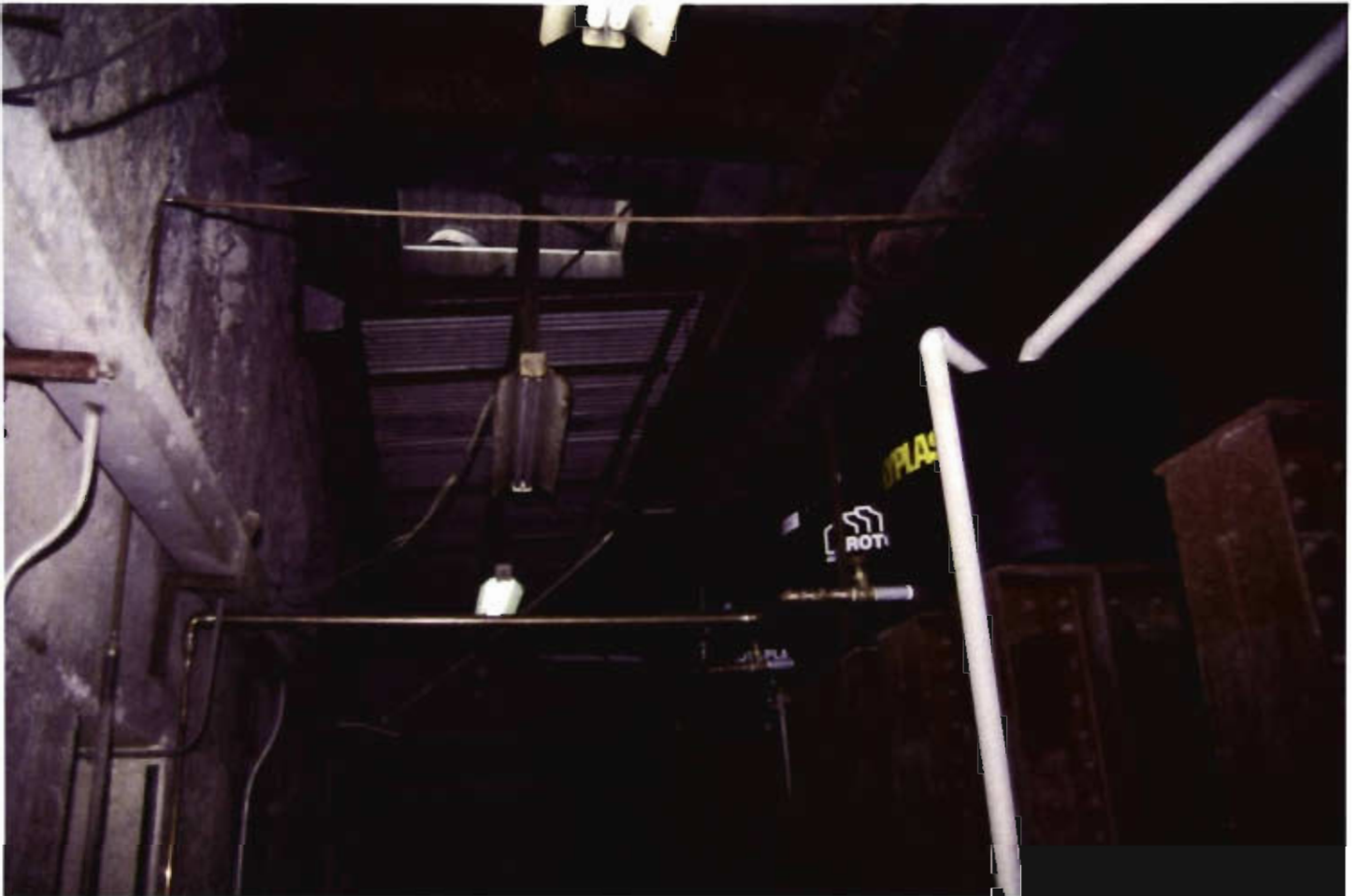
Sistema de almacenamiento del agua pluvial construido en 1999 debajo del Monumento a la Revolución. El agua de lluvia, almacenada en tres tinacos, fue utilizada para el uso de los baños públicos.
