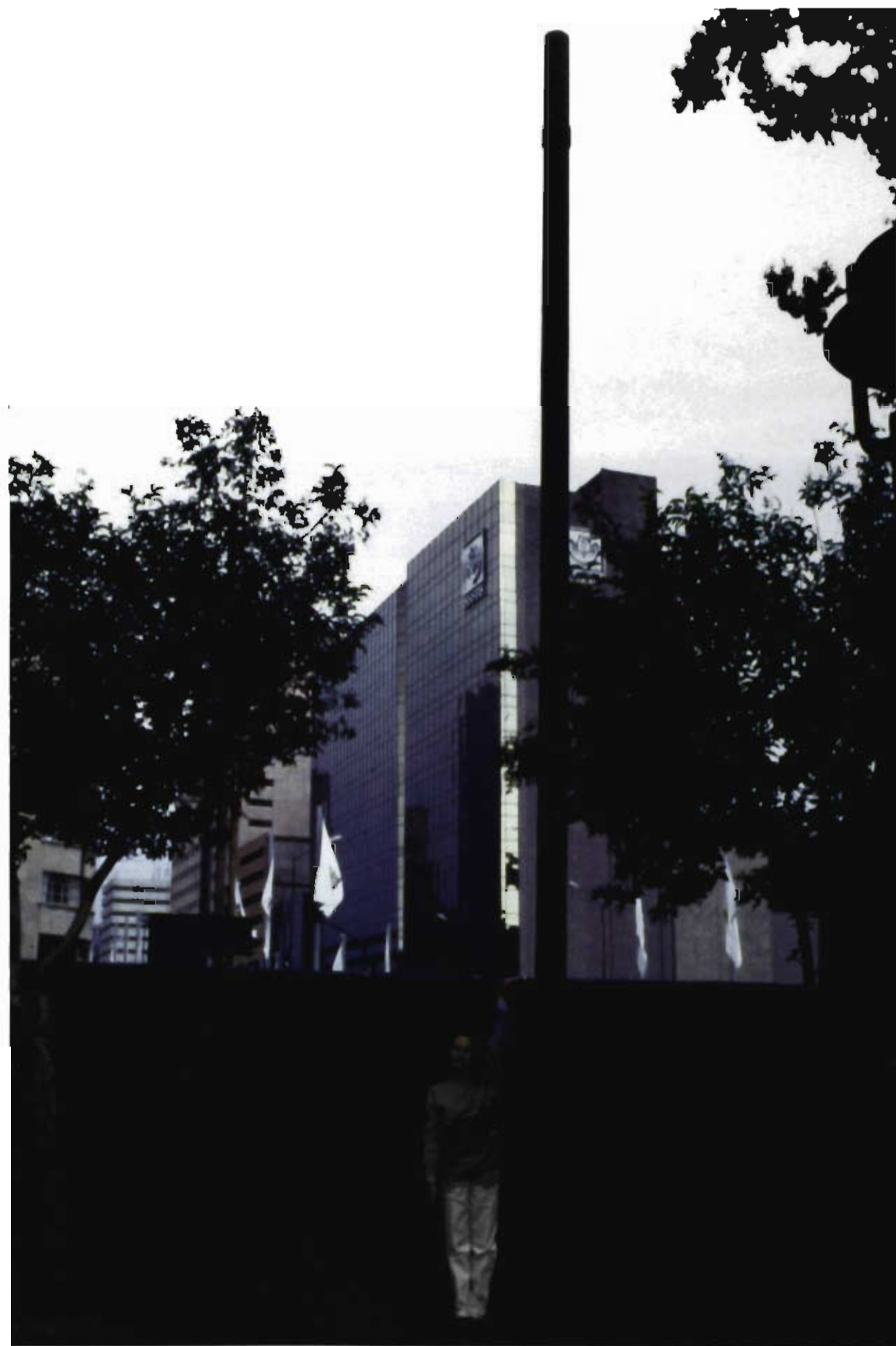
Tubo de una antigua bomba de agua en el Monumento a la Revolución, 1996. En 1934 el piso donde está parada la persona se encontraba en la parte más elevada de dicho tubo.
