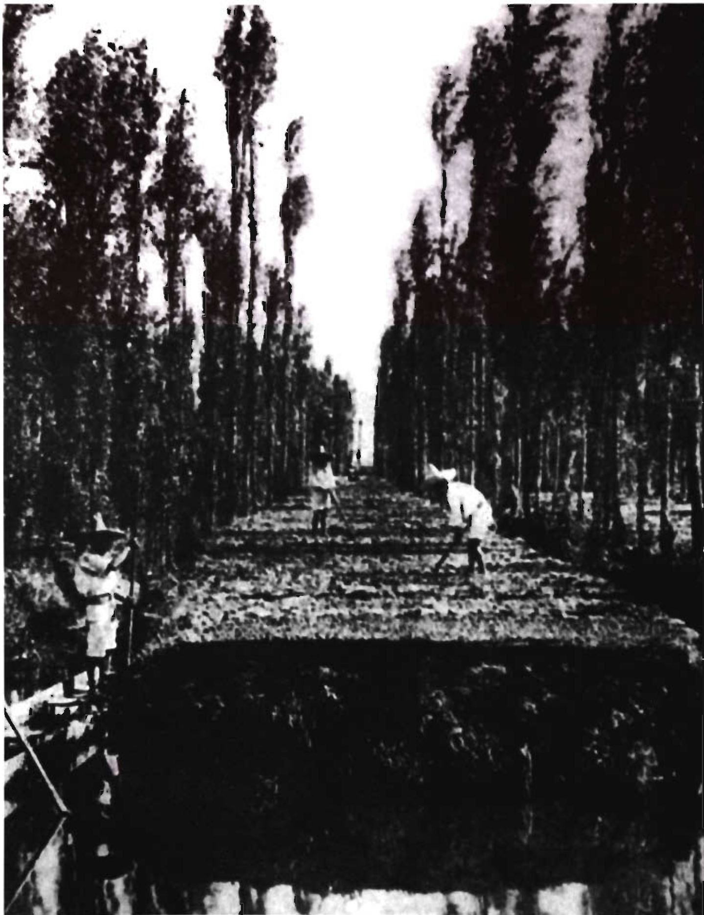
Construcción de una chinampa a principios del siglo XX. En la compactación de las capas de tierra los espigados árboles llamados ahuejotes eran determinantes, además de su función como reguladores del sol y de la temperatura.
