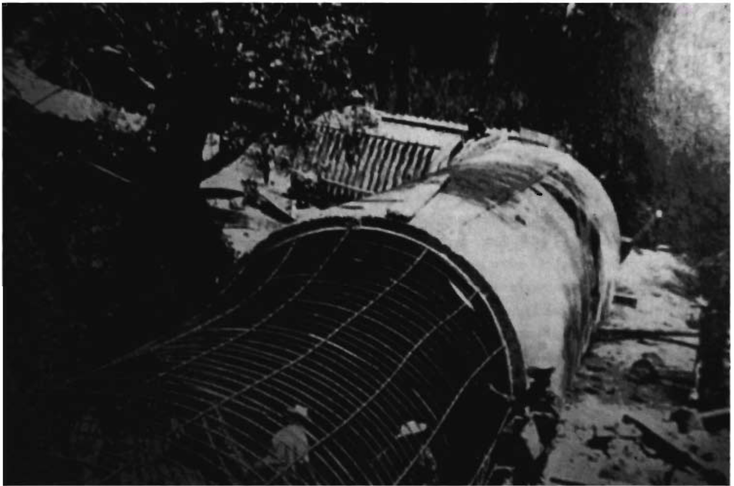
El río de la Magdalena, entubado hacia principios de los años sesenta. El criterio fue edificar un rubo sobre el cause del río para posteriormente pasar sobre él una vía de asfaltos. Se cambió así, el agua por autos.
