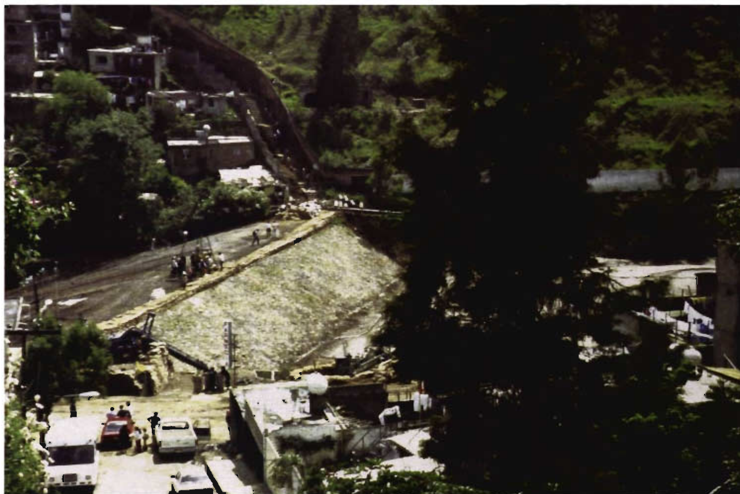
Presa Tequilazco, 1992. En la foto, la cortina de la presa rebasada por el agua que provocó una de las inundaciones parciales más dramáticas de fines del siglo XX en la zona poniente de la ciudad.
