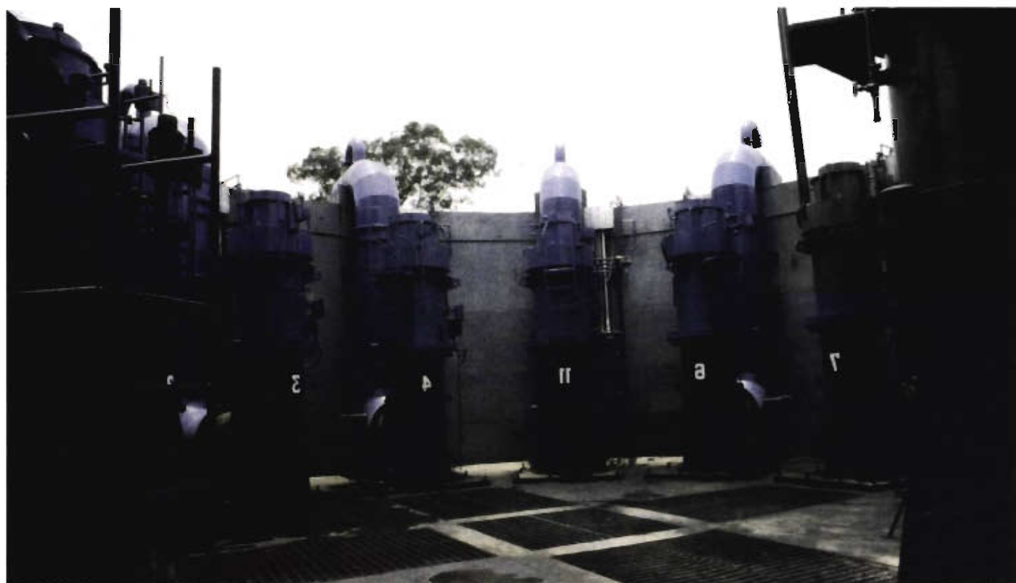
Planta de bombeo Central de Abastos, 2006. Ubicada a un lado del río Churubusco, sus funciones son vitales para evitar inundaciones en la zona poniente de la ciudad.
