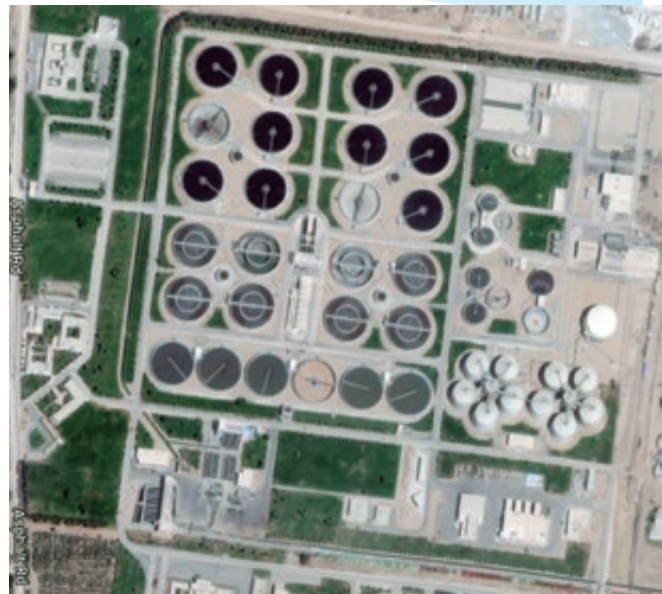
Figura 1. Gabal El Asfar. Vista aérea.
