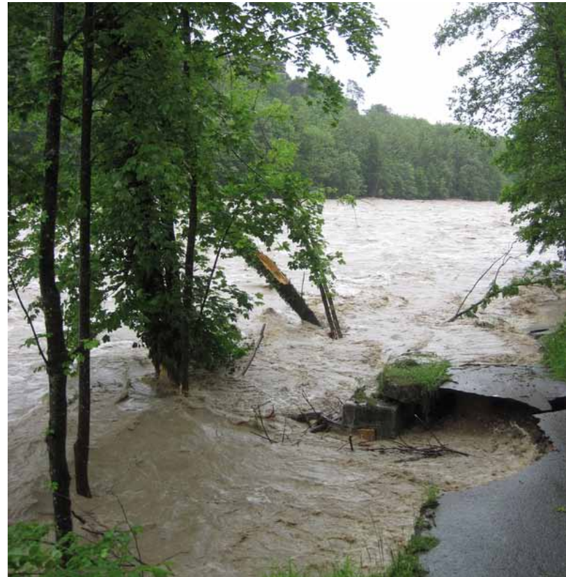
Inundaciones producidas por el desbordamiento de un río
