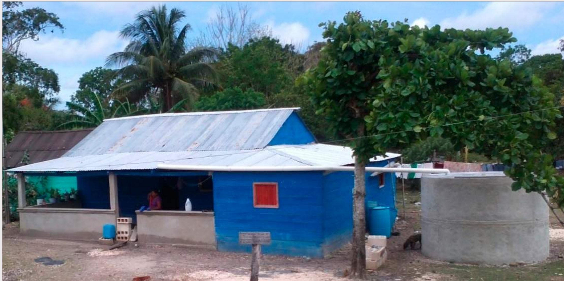
Casa con captación de agua de lluvia en Xpuhil, Campeche. Fotografía de Carlos Alcérreca.
