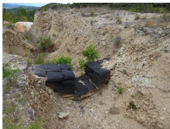
Figura 15. Presa de geocostales
