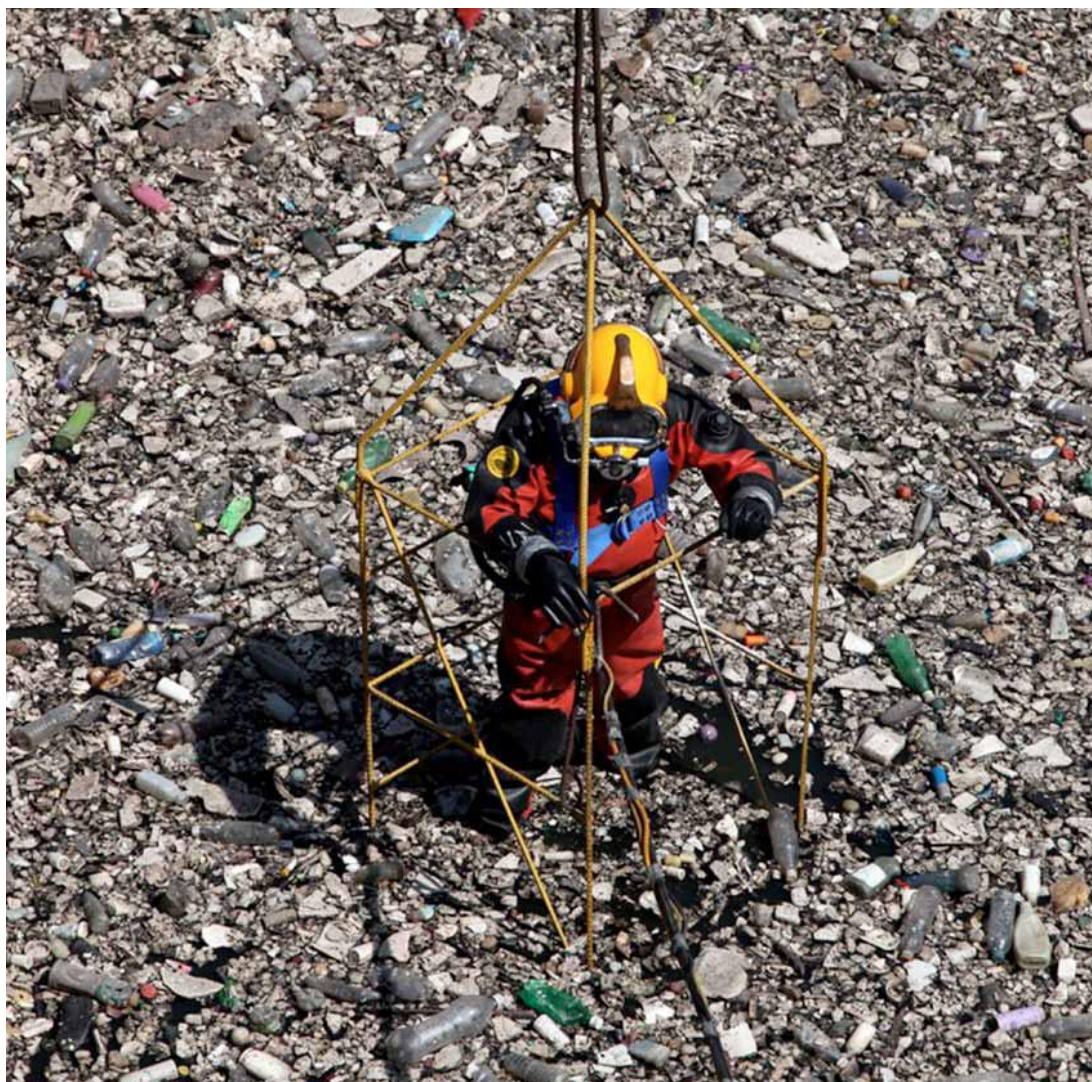
Figura 47: Proceso de inspección en el cárcamo de la planta de bombeo de agua residual 18+500.
