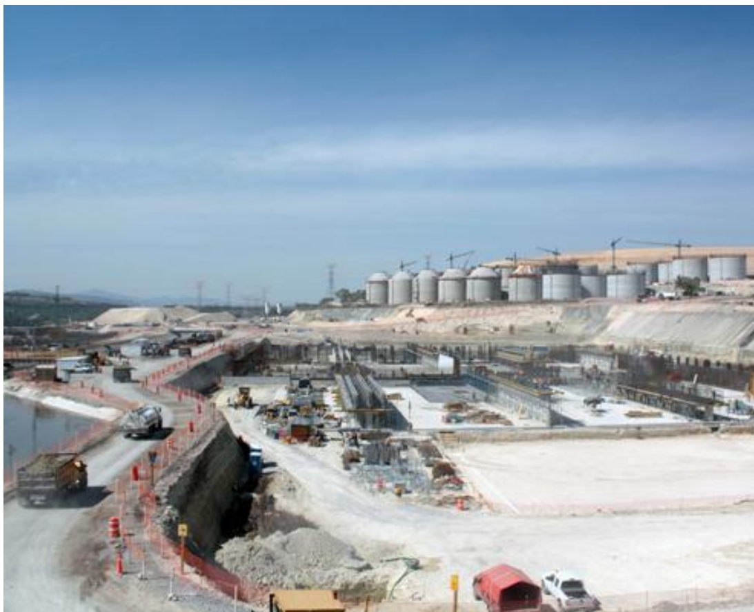
Figura 89: Vista panorámica de avance de obras de la PTAR Atotonilco.
