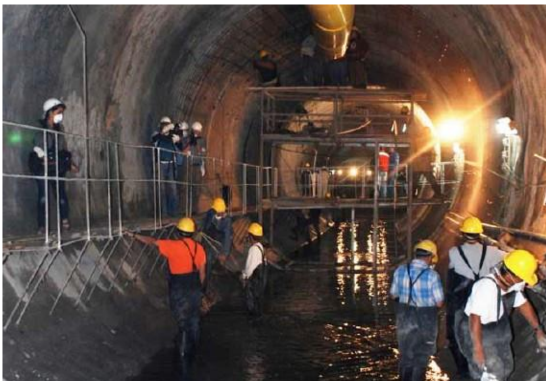
Figura 86: Labores de mantenimiento y reparación en el Túnel Emisor Central.
