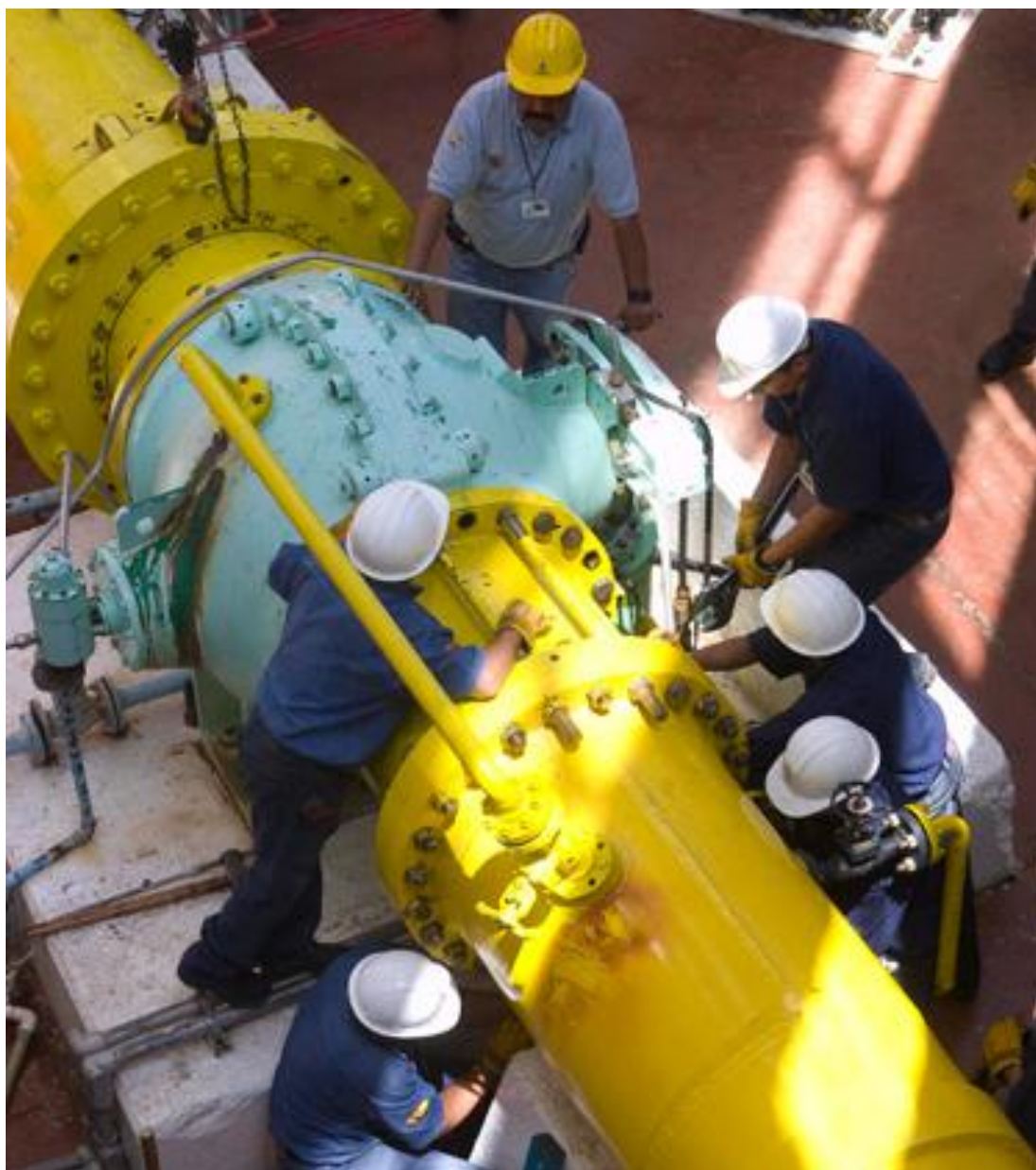
Figura 84: Trabajos al interior de una de las plantas de bombeo del sistema Cutzamala.
