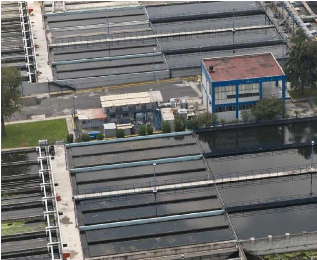
Figura 88: Planta de tratamiento de aguas residuales Cerro de la Estrella.
