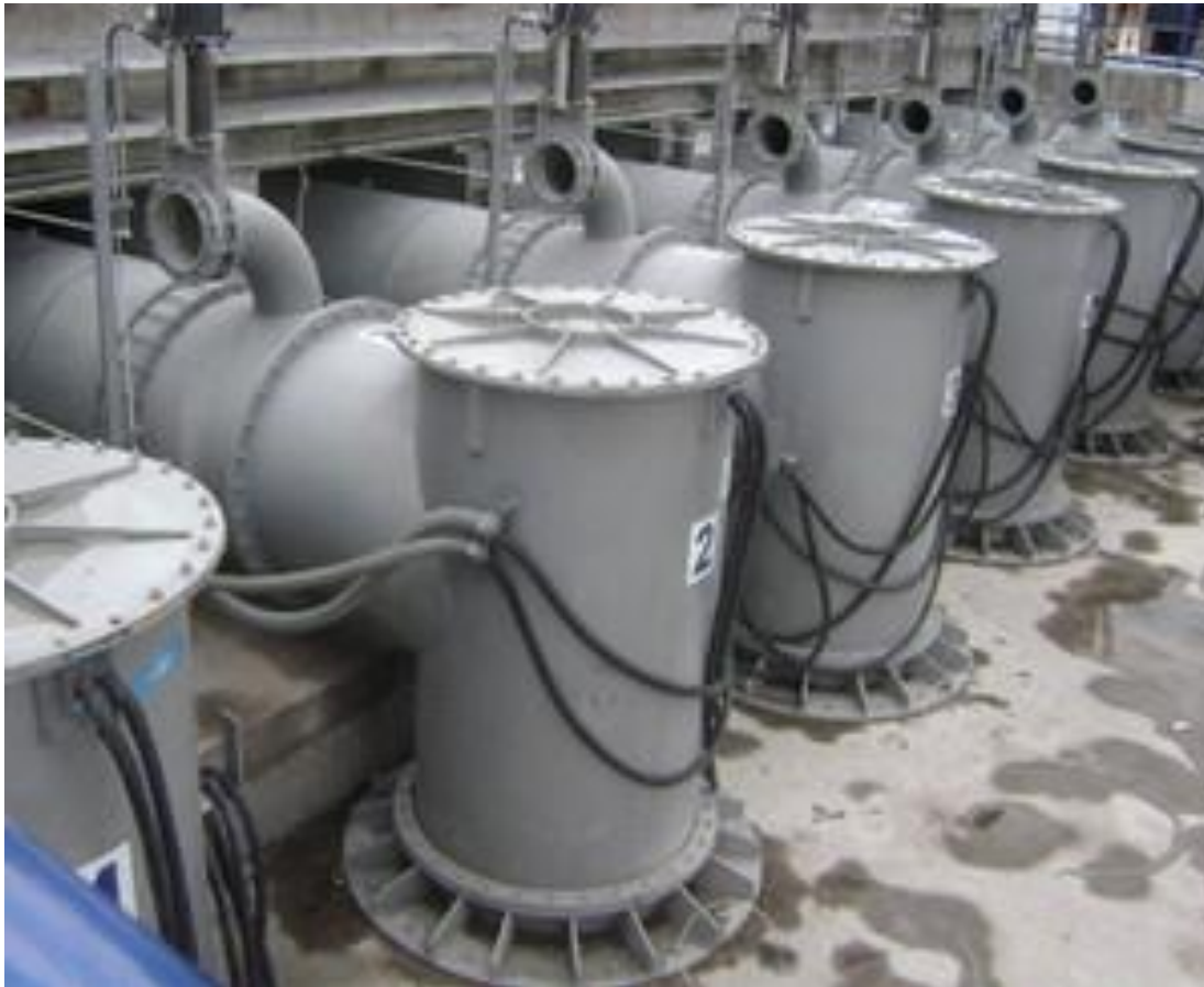
Figura 87: Bombeo de aguas residuales.
