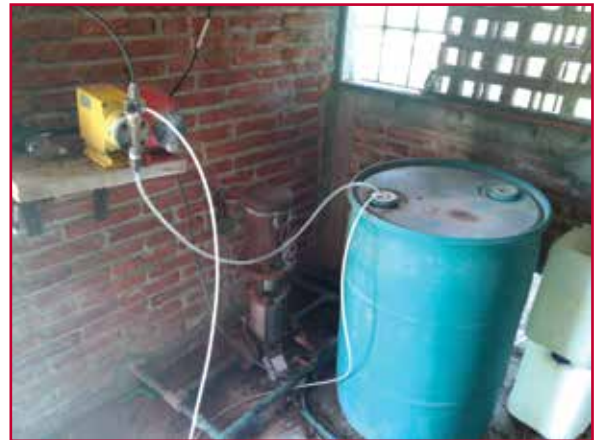
Ilustración 2.7 Sistema de cloración (IMTA, 2013)
