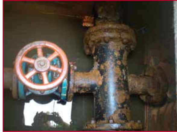
Ilustración 2.9 Crucero con válvula de seccionamiento
