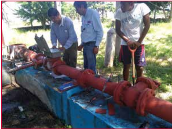
Ilustración 2.17 Medición de gasto en pozo con equipo portátil (IMTA, 2013)
