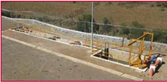
Ilustración 2.13 Obra de descarga de la red de alcantarillado sanitario a PTAR
