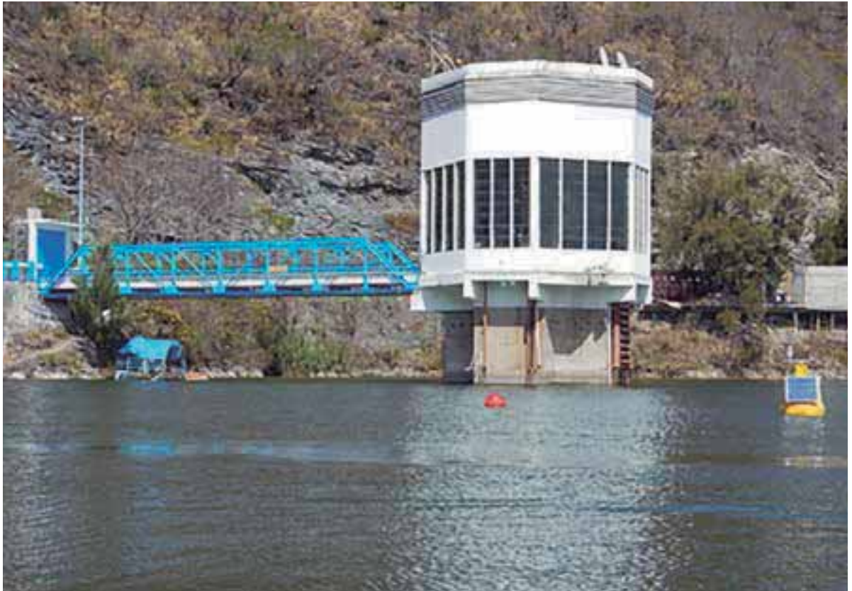
■ Figura 12.8. Obra de toma, presa Valle de Bravo
