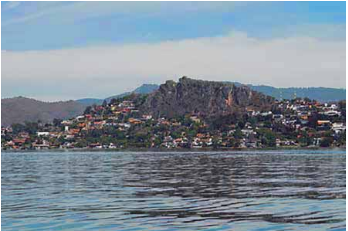
■ Figura 12.9. Presa Valle de Bravo
