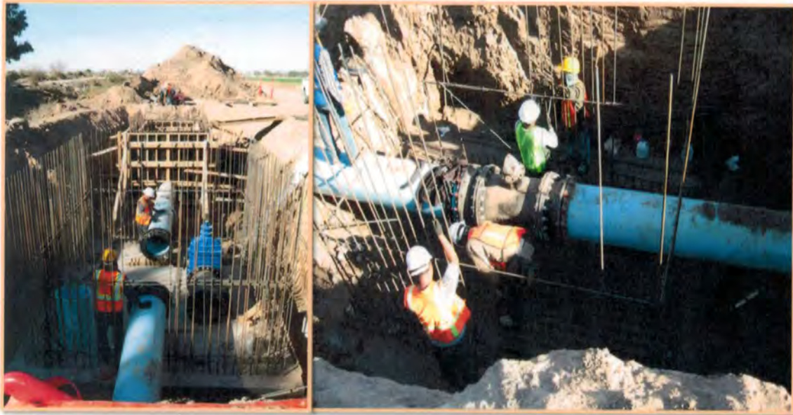
Figura 3.2 Construcción del acueducto de 70 lps Fuente: CESPM.
